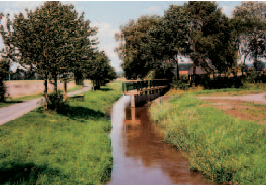
Blick auf das neu gestaltete Verteilerbauwerk an der Bifurkation in Melle/Gesbold (Foto: Ute Schreiber)
