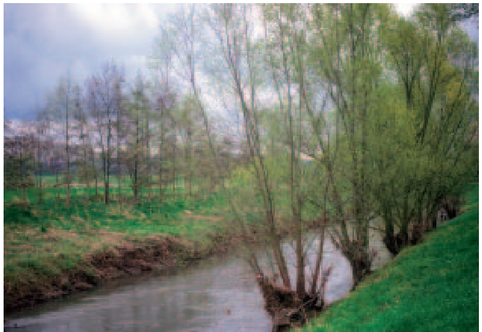
In den 60-er Jahren wurde die Nidda auf langen Strecken für ein 100-jährliches Hochwasser (HQ 100) ausgebaut. (Foto: Th. Paulus)
