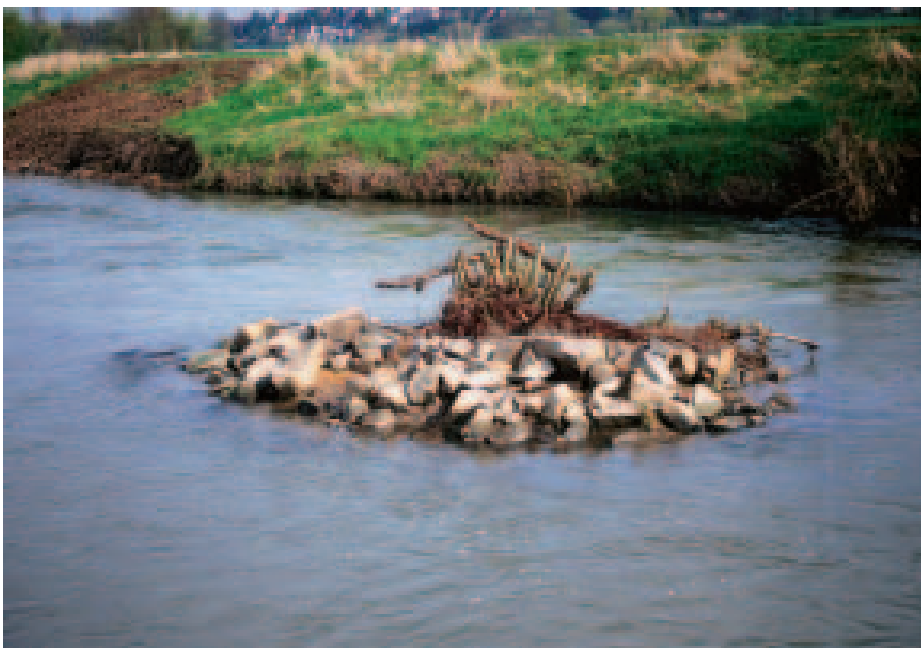
Die Uferböschung wurde teilweise entfernt und das Gewässerbett verbreitert. Zum Teil blieb der alte Steinsatz stehen und als Gewässerinsel in der Mitte des Gewässerbettes belassen. (Foto: Th. Paulus)
