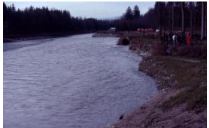
Bild 3: Aufweitung der Emme bei Utzenstorf (Kanton Bern, Schweiz); Zustand nach Realisierung der 1. Etappe, gewollte Uferabbrüche (Foto: M. Jäggi)
