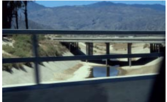
Bild 1: Mit Beton verkleidetes Gerinne bei Palm Springs (Kalifornien, USA) (Foto: M. Jäggi)
