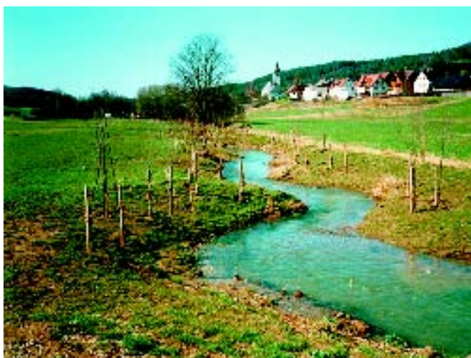
Bild 5: Unmittelbar nach Renaturierung: Beschattung, abwechslungsreicher Untergrund als Lebensraum für Wirtsfische und Muscheln, natürliche Uferbefestigung (Foto: WWA Bayreuth)
