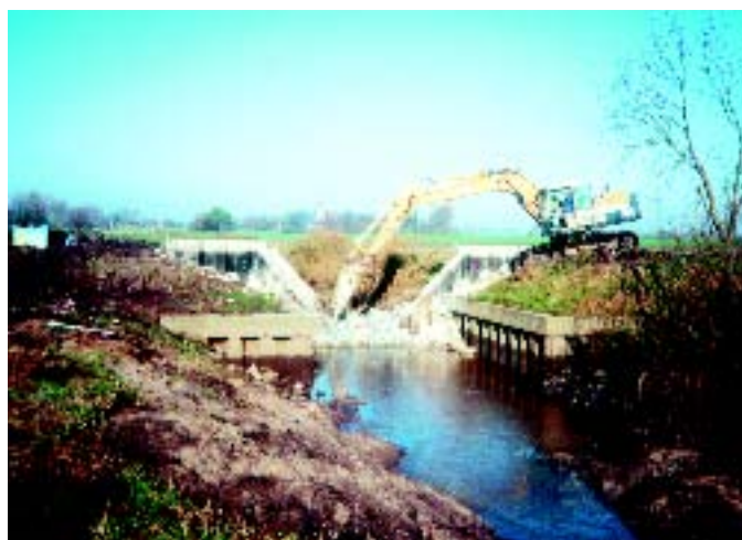
Bild 2: Betonabbrucharbeiten am Wehrkörper
