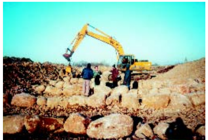
Bild 5: Bauberatung zum Zeitpunkt des Setzens der Querriegel (Foto: R. Barz)
