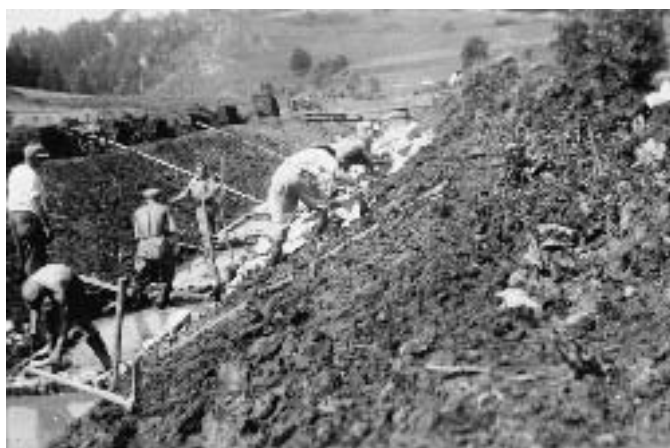
Bilder 2 und 3: Ausbau des Ailsbaches von 1937 bis 1952 (Fotos: WWA Bayreuth)
