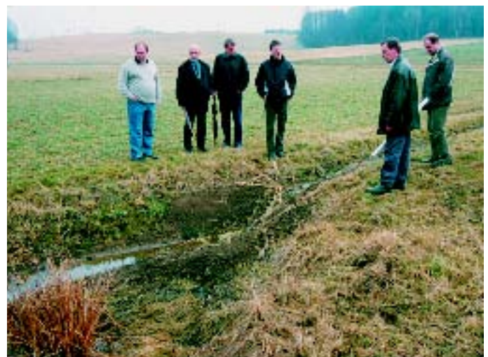
Bild 6: Sedimentfallen halten Einträge aus den angrenzenden Flächen zurück
