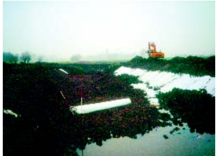
Bild 4: Herstellen der Steinschüttung auf Geotextil (Foto: R. Barz)
