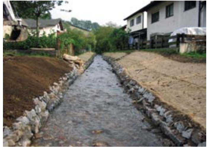
Bild 4: Umgestaltung von Gewässersohle und Ufer im Bereich der beengten Bachparzelle (Bild: G. Schmidt)
