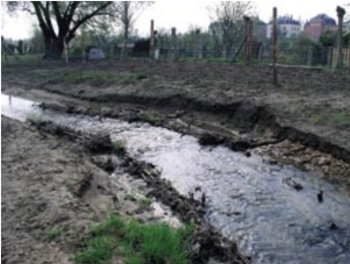
Bild 3: April 2006 – Schadbild: Auskolkung am Prallhang mit hinterspülter Faschine (Bild: P. Zinnecker)
