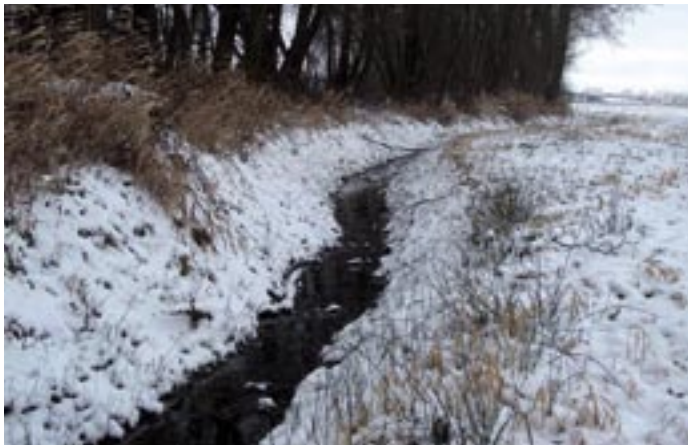
Bild 2: Die Räumung wurde möglichst gewässerverträglich ausgeführt. Das Räumgut wurde in den angrenzenden Flächen einige Tage zwischengelagert und von den Landwirten entfernt oder eingearbeitet.
