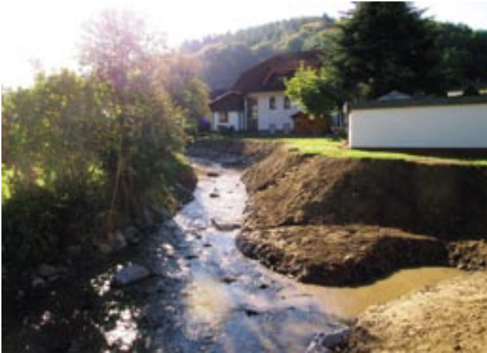
Bild 3: Bauarbeiten am Grundelbach Herbst 2005 (Bild: IB Eiling)
