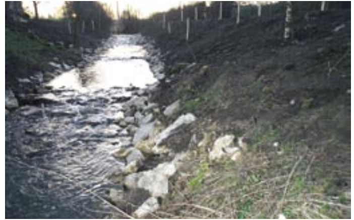
Bild 3: Die Raue Rampe unmittelbar nach der Fertigstellung
