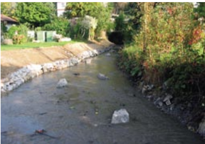
Bild 5: Gewässeraufweitung nach Abschluss der Bauarbeiten (Bild: G. Schmidt)
