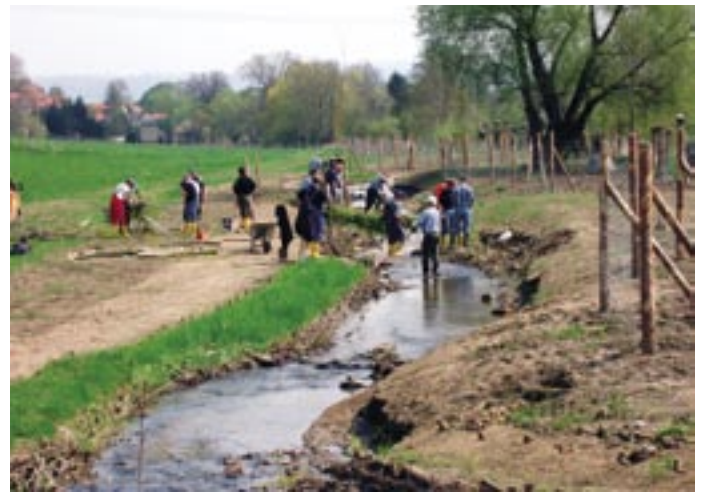
Bild 2: Ufersicherung mittels ingenieurbioologischen Bauweisen am Kaitzbach (Bild: A. Schnauer)
