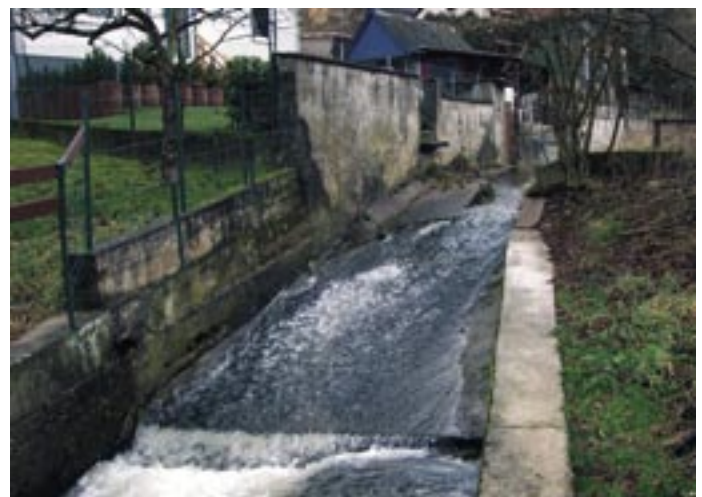
Bild 2: Ehemaliges Wehr – Wanderbarriere für Fische und Kleinlebewesen (Bild: IB Eiling)
