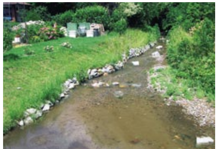
Bild 6: Gleicher Gewässerabschnitt wie Bild 5 im Sommer 2006 (Bild: IB Eiling)
