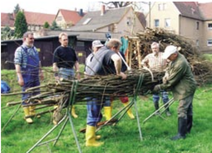
Bild 1: Binden einer Lebendfaschine durch die Teilnehmer des Nachbarschaftstages (Bild: A. Schnauer)
