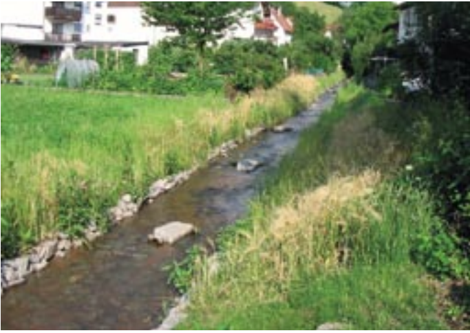
Bild 7: Renaturierter beengter Bereich Sommer 2006 (Bild: G. Schmidt)
