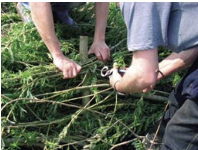
Bild 5: 26. April 2006 – Befestigung des oberen Flechtwerkes an der Weidenstange (Bild: P. Zinnecker)
