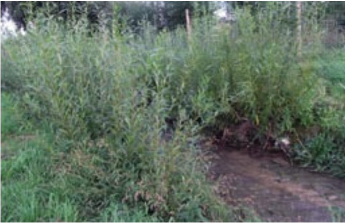
Bild 7: September 2006 – Austrieb des Flechtzaunes (hinten) sowie der Lebendfaschine (vorn) (Bild: A. Schnauer)
