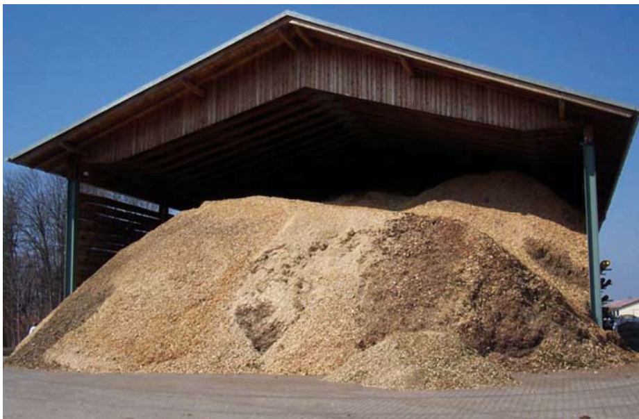
Bild 2: Silo der Biomasse Dorfheizung
