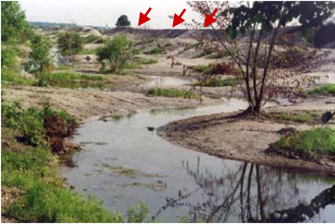
Bild 2: Unmittelbar nach der Renaturierung: Moosbach mit deutlich verbessertem Hochwasserrückhaltevermögen. Rot Markiert: Der Lärmschutzwall (Massenausgleich)
