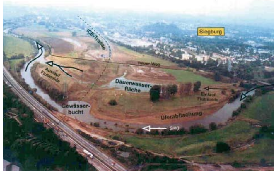
Bild 1: Flutmulde Siegburg nach Fertigstellung im Jahr 2000; dargestellt sind der Einlauf (rechts im Bild), die Dauerwasserfläche (Bildmitte) und der Auslauf (links im Bild) sowie die ICE-Trasse (Foto: Züblin AG, September 2000)
