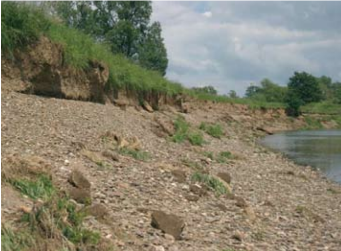
Bild 3: Böschungsabbrüche nach dem letzten Hochwasser im Mai 2006 mit einem Abfluss von ca. Q = 300 \text{ m}^3/\text{s} (Foto: N. Wesselborg, Juni 2006)
