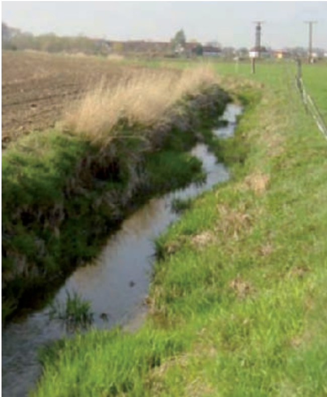
Bild 1: BA 02 Vorher: Der Bachlauf weist in Folge der Begradigung Ufer- und Sohlenerosionen auf. Fehlende Ufergehölze verstärken dieses noch.
