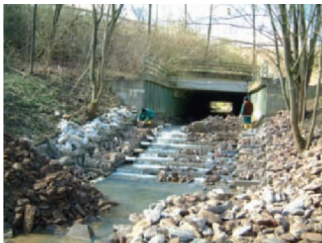
Bild 6: Pfeiffenbrinkscher Sohlenabsturz (Foto: Koordinationsbüro)
