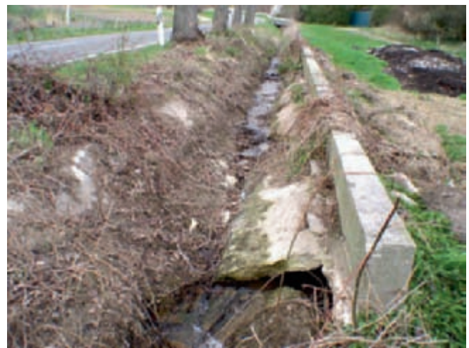
Bild 1: Auch Reparaturen konnten nicht verhindern, dass der Bach sein eigenes Bett sucht.
