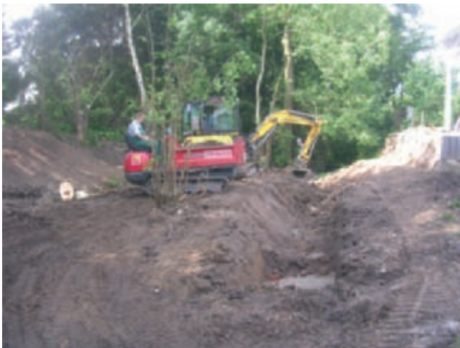
Bild 12: Einsatz von Minibagger und Raupenkipper (Foto: Koordinationsbüro)
