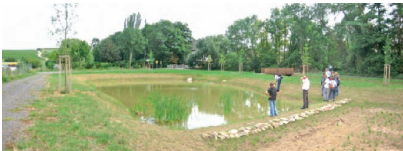
Bild 3: Im Nebenschluss das neue Regenrückhaltebecken mit vorgelagertem Materialfang kurz vor der neu geschaffenen Mündung des Mölsheimer Bachs in die Pfrimm. (Foto: W. Herget)
