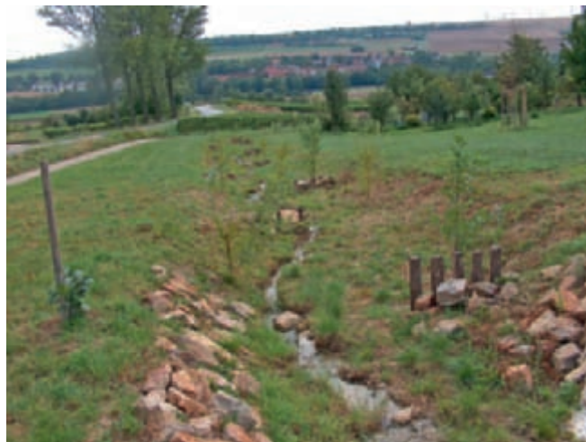
Bild 4: Bei Abflüssen zwischen 10 l/s und 2250 l/s (10 jährliches Ereignis) kommen in gefällereichen Strecken Strömungslenker zum Einsatz. (Foto: Th. Paulus)
