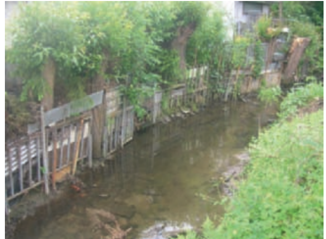
Bild 11: Naturferne Ufersicherung/Einengung des Bachprofils (Foto: Koordinationsbüro)
