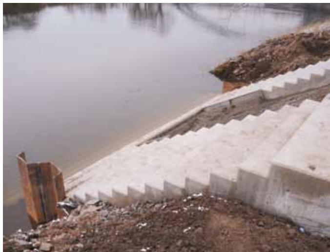
Bild 9: Bauausführung – Betonage abgeschlossen
