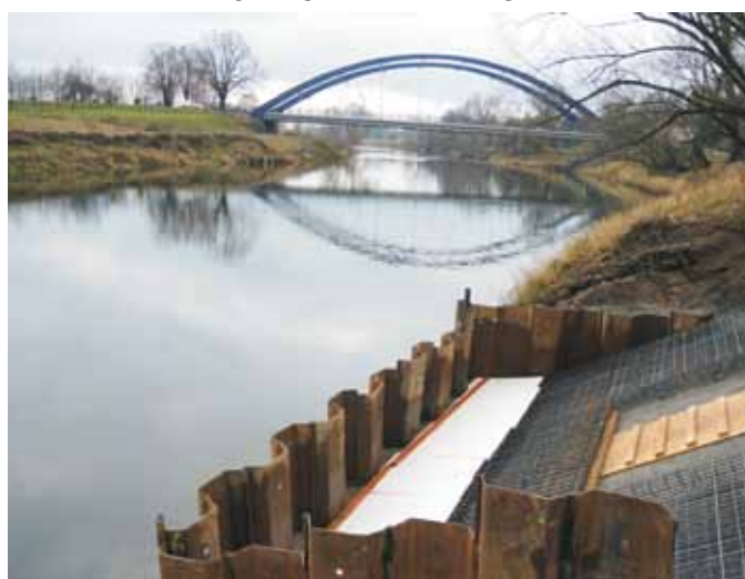
Bild 8: Bauausführung – eingebaute Bewehrung
