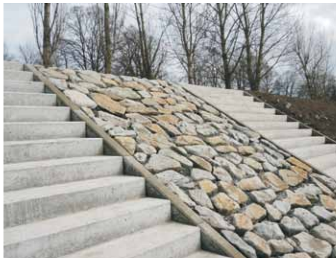
Bild 10: Bauausführung – Zwischenbereich zwischen Landzugängen befestigt
