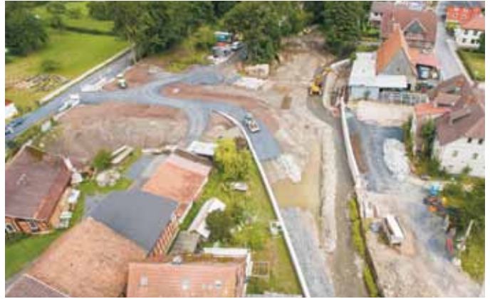
Bild 14: Luftbildaufnahme Bauarbeiten 1. Bauabschnitt, (HSP)
