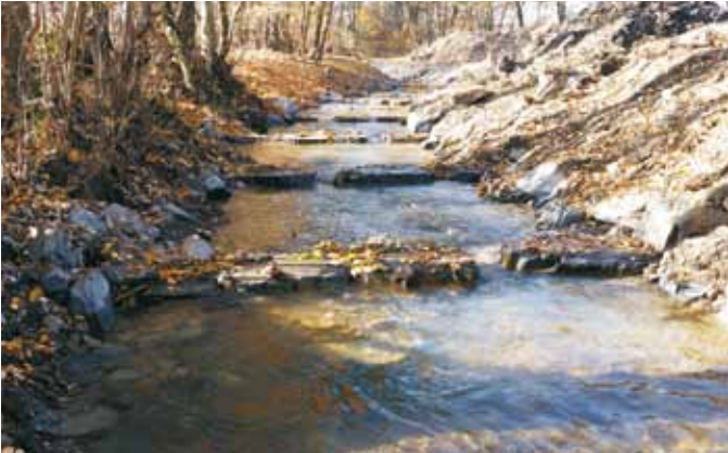
Bild 15: Umgehungsgerinne Wehr Feldmühle, (HSP)
