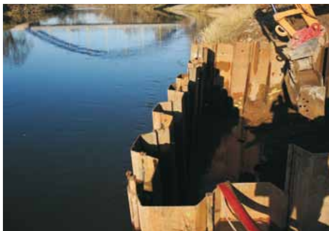
Bild 7: Bauausführung – hergestellter Spundwandkasten
