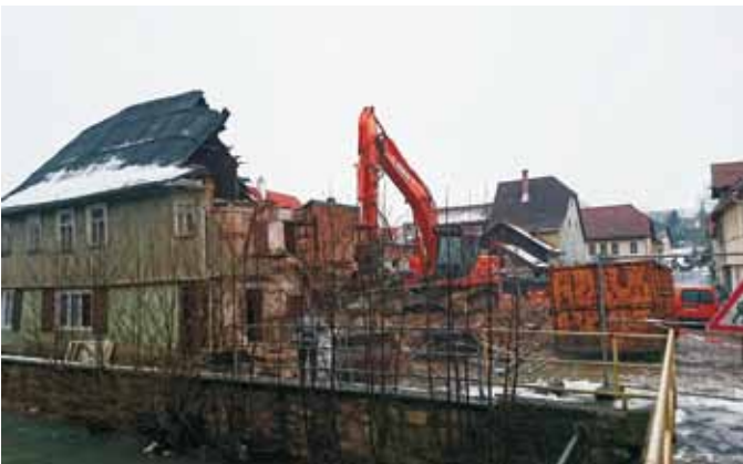
Bild 17: Rückbau eines Wohngebäudes zur Baufeldfreimachung, (HSP)
