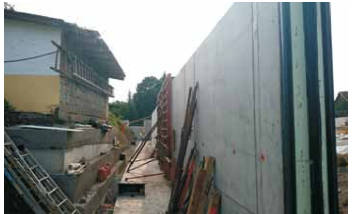
Bild 18: Ausschalung eines fertigen Wandsegmentes im Bereich einer Gebäudeunterfangung (2. Bauabschnitt), (HSP)
