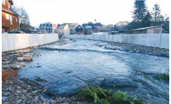
Bild 16: Beginn Gewässerbettgestaltung 2. Bauabschnitt, (HSP)
