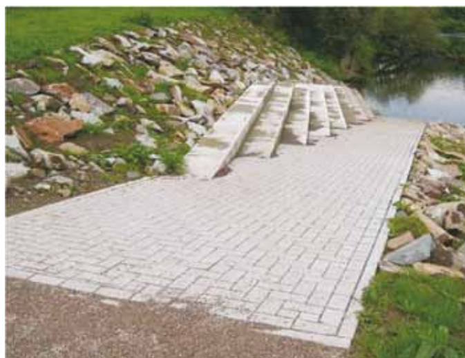
Bild 4: Stufenanleger – Ausführungsbeispiel
