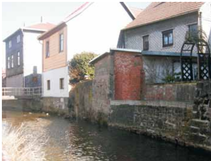
Bild 7: Werranahe Bebauung auf der Ufermauer, (Quelle: HSP)
