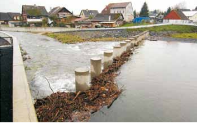
Bild 13: Treibholzperre in Funktion, (HSP)
