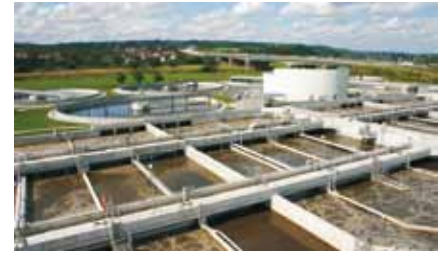
Kläranlage Dresden-Kaditz (Stadtentwässerung Dresden GmbH)
