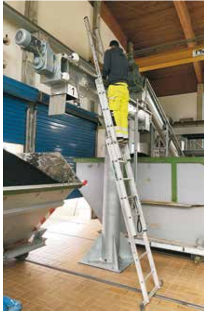
Abb. 1: Arbeiten auf der Leiter (Foto: SOWAG Zittau mbH)
