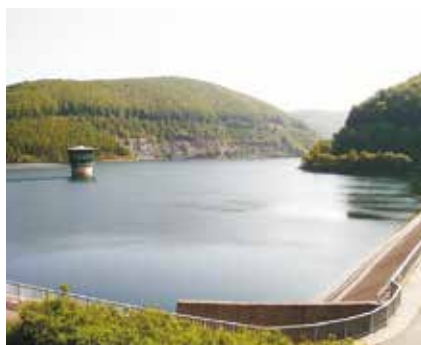
Abb. 2: Talsperre Schönbrunn (Foto: Thüringer Fernwasserversorgung)
