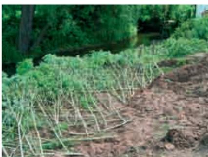
Abb. 17: Buschlage, kreuzweise versetzt in zwei
