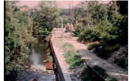
Bereits fertiggestellter Abwasserkanal zur neuen Kläranlage mit verlorener Spundwand
