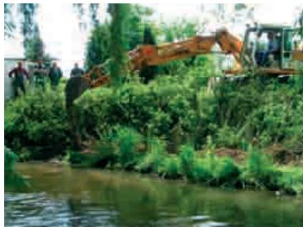
Abb. 8: Weidenspreitlage – Nach Einbau der Weidenäste erfolgt die Verfüllung des Grabens am Böschungsfuß. (Foto: Herr Dittrich)
