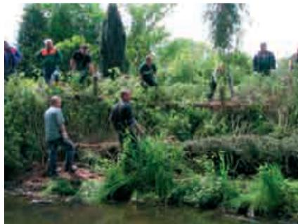
Abb. 9: Nach Fertigstellung der Weidenspreitlage: Einbau der Raubäume zur Böschungsfußsicherung (Foto: Herr Dittrich)
