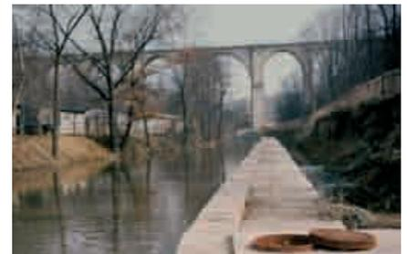
Bereits fertiggestellter Abwasserkanal zur neuen Kläranlage (zweigeteiltes Eiprofil - Fertigteile)
