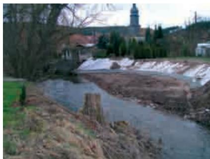
Abb. 3: Der Kolk am 21.1.2008. Deutlich erkennbar ist das Ausmaß des Abbruches. Blick vom Gegenufer entgegen der Fließrichtung. (Foto: Herr Dittrich)
