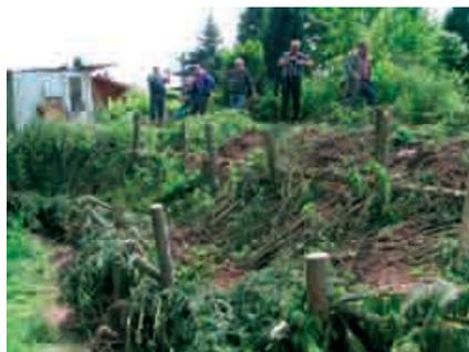
Abb. 10: Weidenspreitlage nach Übererdung – als letzter Arbeitsschritt müssen noch die Pfähle bis auf 10 cm über der neuen Böschungsoberkante abgesägt werden. (Foto: Herr Dittrich)
