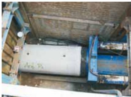
Abb. 3: Unterirdischer Rohrvortrieb
