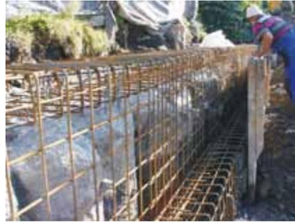
Bewehrung für Vormauerung der Bohrpfahlwand
