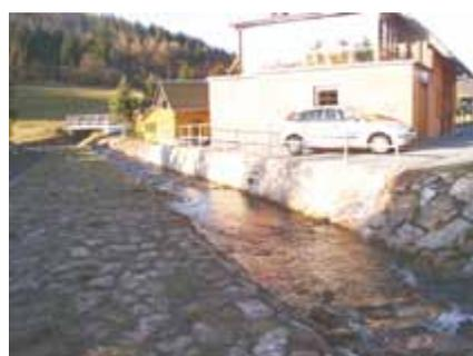
Fertiggestellte Ufermauer mit Bohrpfahlwand
