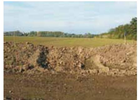
Abb. 5: Abgeschobener Mutterboden
