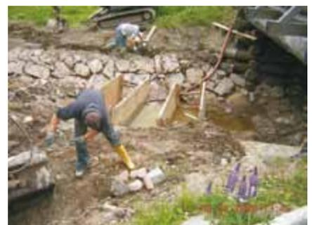
Sohlsicherung mit Querriegel (Herdmauer)
