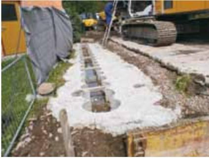
Beginn der Bohrarbeiten für Bohrpfahlwand mit Bohrschablone
