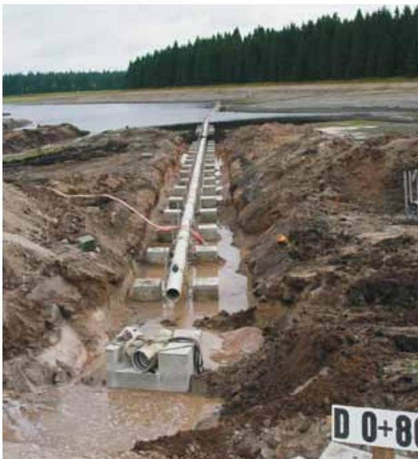
Bild 5: Detail Rohrwiderlager
