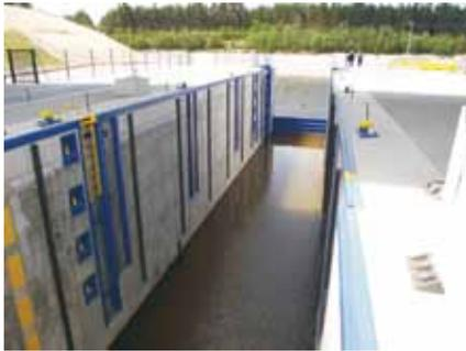
Abb. 9: Innenansicht Schleuse mit Stemmator Oberhaupt, Juni 2011 (Quelle: IL AG)
