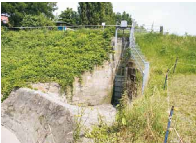
Abb. 2: Deichsiel vor der Instandsetzung
