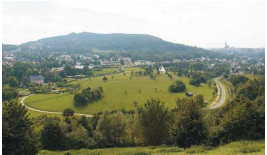
Sanierte Hammerberghalde - Blick über Bad Schlema nach Schneeberg
