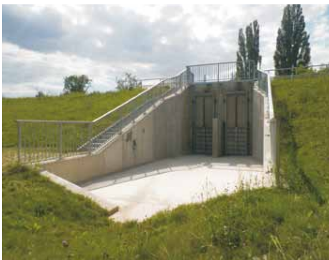
Abb. 11: Siel-Polderseite nach Fertigstellung
