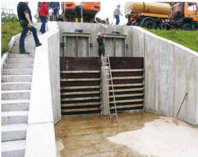
Abb. 10.1: Vorbereitung Dichtheitsprüfung beim Einbau der Schützen
