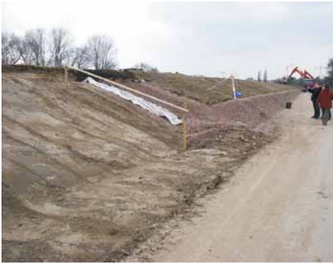
Abb. 8: Bau des Stützkörpers
