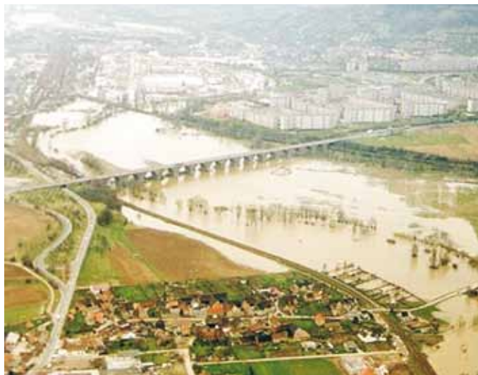
Abb. 2: Hochwasser der Saale im April 1994 bei Jena (Quelle: D. Stremke, LaNaServ)
