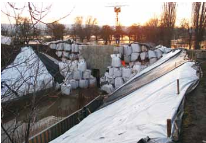
Abb. 6: Maßnahmen zur Hochwasserabwehr mit Big-Bags im Winter 2010/2011
