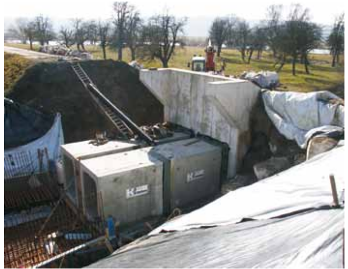
Abb. 9: Bau des Deichsieles
