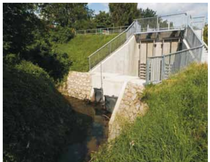
Abb. 12: Siel-Elbseite nach Fertigstellung
