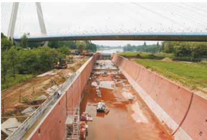
Abb. 5: Bautätigkeiten am Wehr bei Ransern
