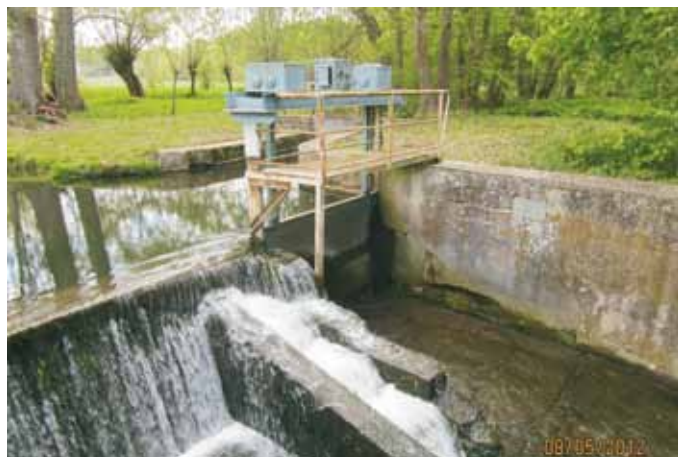
Abb. 1: Alte Wehranlage Seebach
