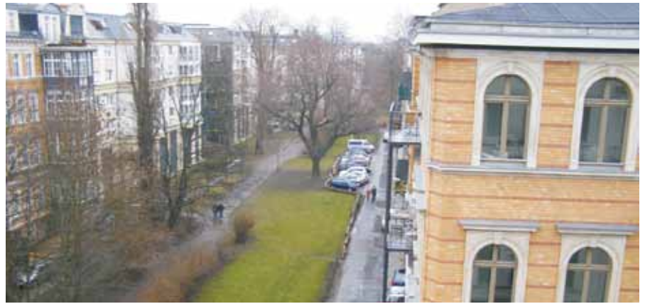
Bild 3: Verrohrter und überbauter Abschnitt des Elstermühlgrabens vor Baubeginn
