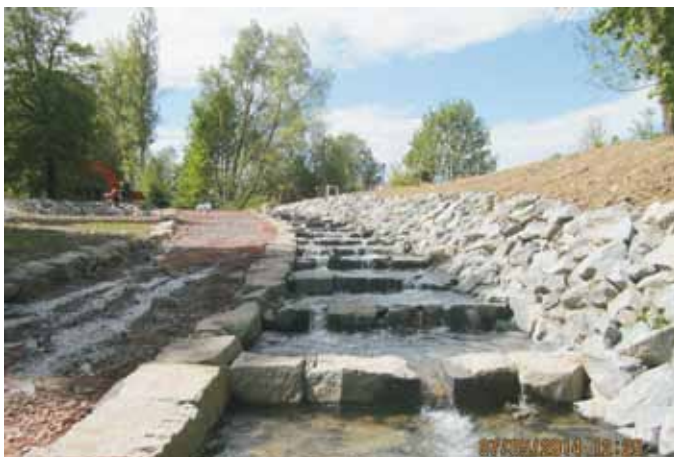
Abb. 5: Fertiggestellte Sohlgleite
