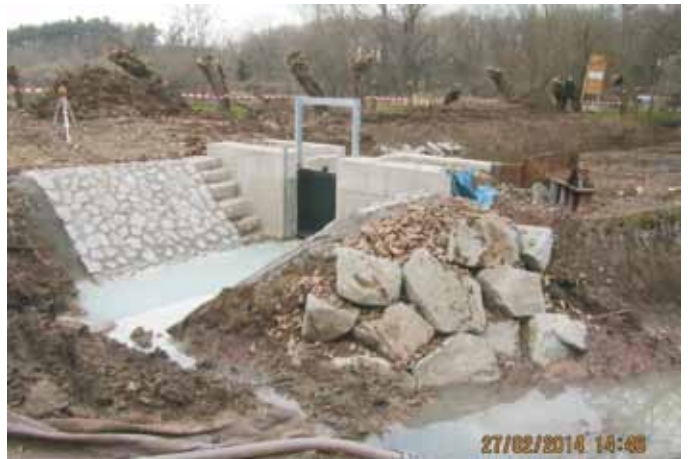
Abb. 4: Neues Einlaufbauwerk Mühlgraben
