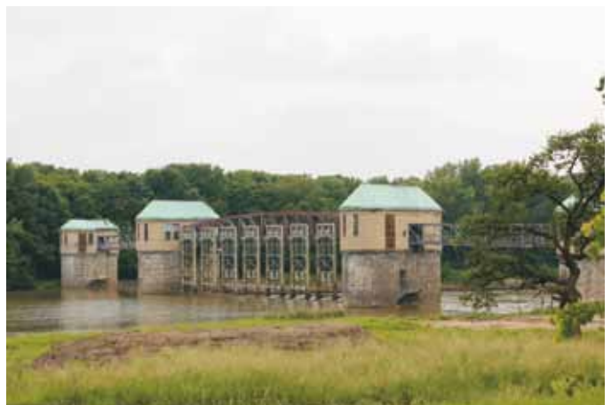
Abb. 6: Blick auf das Wehr bei Ransern
