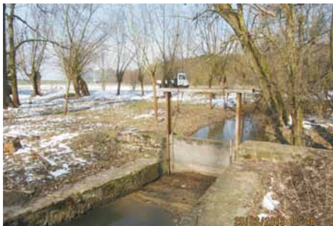
Abb. 2: Altes Einlaufbauwerk Mühlgraben
