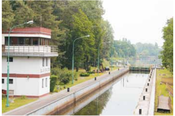
Abb. 9: Blick auf die Schleuse Zacisze
