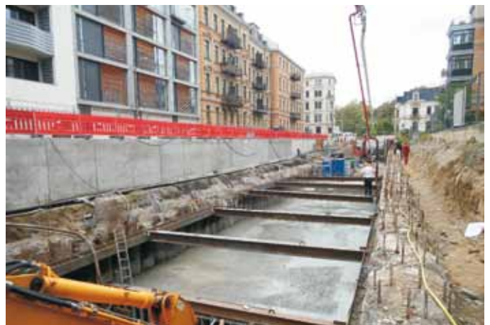
Bild 7: Baustelle Elstermühlgraben TBA 3.3 - Los F5 Grabenausbau - Errichtung der Gewässersohle - derzeitiger Baustand (Quelle - Foto Amt für Stadtgrün und Gewässer)
