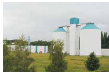
Zentrale Kläranlage der Stadt Chemnitz
