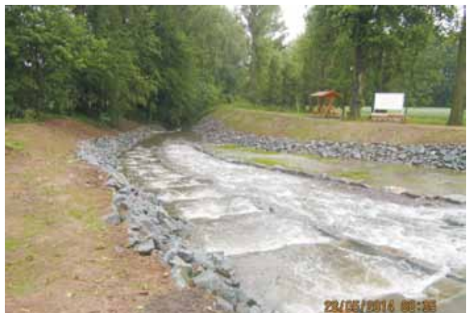
Abb. 6: Fertiggestellte Sohlgleite bei Stärkerer Wasserbeaufschlagung
