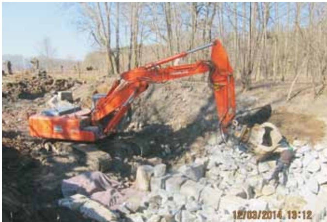
Abb. 3: Herstellung der Becken und Raugerinne
