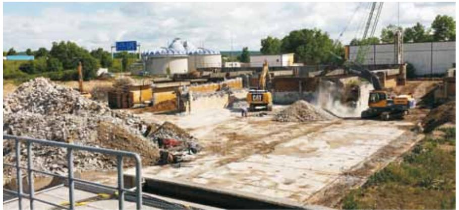
Abb. 4: Baufeldfreimachung für den ersten Bauabschnitt
