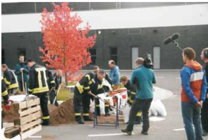
Sandsackverlegung zur Quellkade
