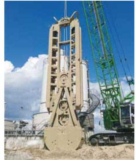
Abb. 5: Schlitzwandgreifer bei der Herstellung der Dichtwand
