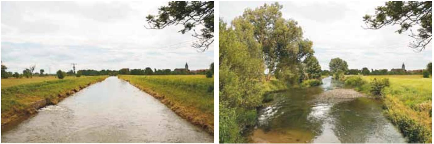
Abb. 3: Derzeitiger Zustand (links) und geplanter Zustand (rechts – Fotomontage der Vorzugslösung) der eingedeichten Gera bei Gebesee (Quelle: TLUG)
