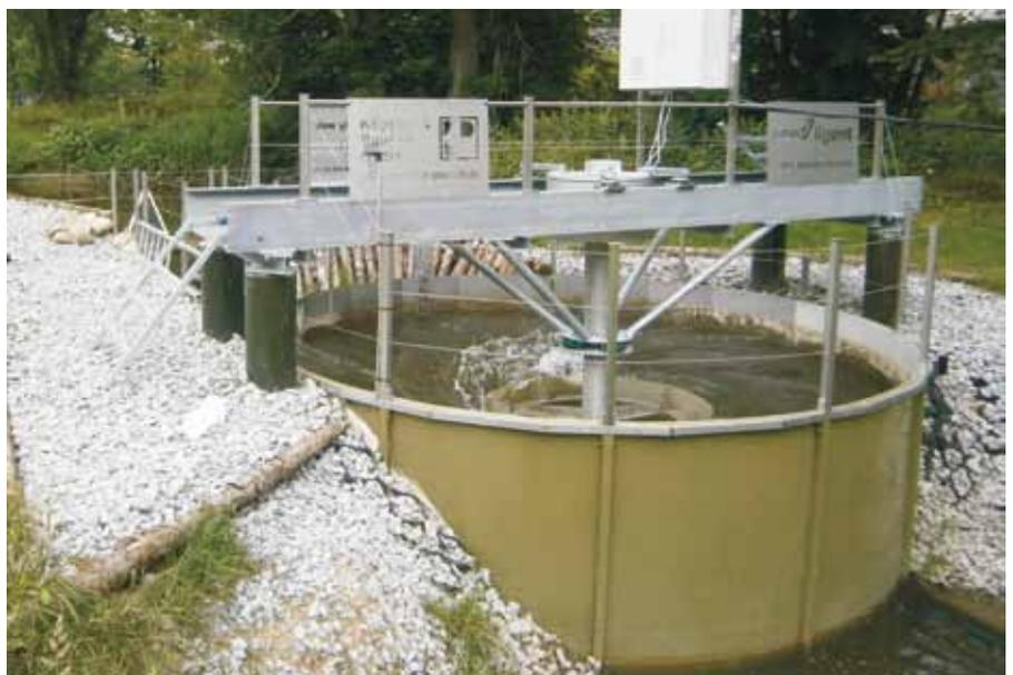
Alle Anlagenparameter richten sich primär nach der Verträglichkeit für aquatische Organismen. Erst wenn diese Bedingungen erfüllt sind, wird die energetische Optimierung vorgenommen. Zusätzlich ist planerisch die vertikale Anordnung des Beckenbodens zu bestimmen, da diese für die Fischdurchgängigkeit von entscheidender Bedeutung ist.
