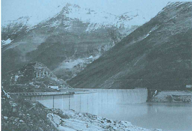
Bild 3: Mooser- (links) und Drossensperrmauer
