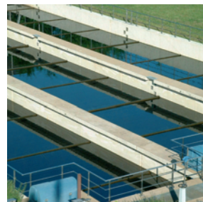
Kläranlage Schwelm Landesverband NRW
