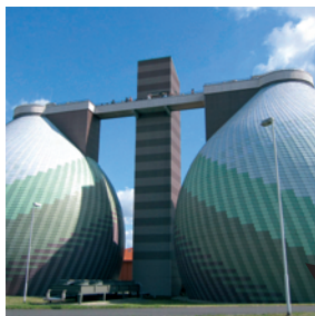
Klärwerk Magdeburg-Gerwisch Landesverband Nord-Ost
