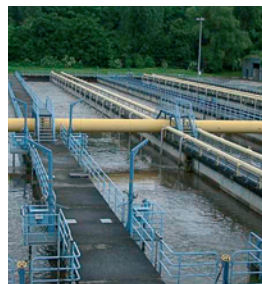
Kläranlage Stuttgart-Mühlhausen Landesverband Baden-Württemberg
