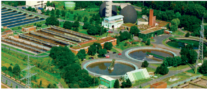
Kläranlage Mainz Landesverband Hessen/Rheinland-Pfalz/Saarland
