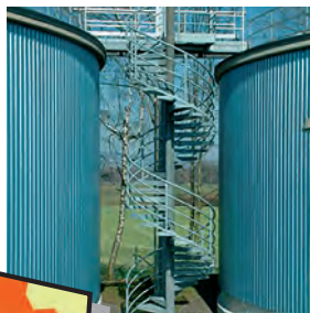
Kläranlage Freilassing Landesverband Bayern
