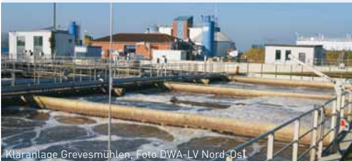
Kläranlage Grevesmühlen, Foto DWA-LV Nord-Ost
