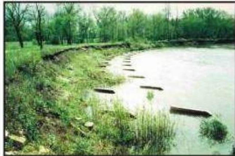
Das Ufer des Wapsipinicon River am 10. Mai 1990 bei Niedrigwasser, 2 Jahre nach Einbau der „Iowa Vanes“
