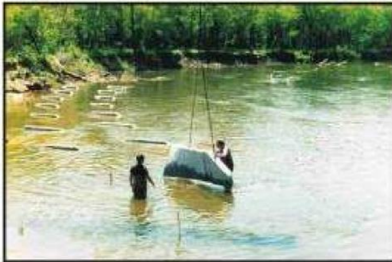
Einbau von „Iowa Vanes“ in den Wapsipinicon River bei Niedrigwasser im Sommer 1988
