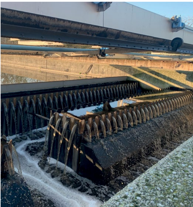
Kläranlage Dessau, Ablauf Vorklärung
