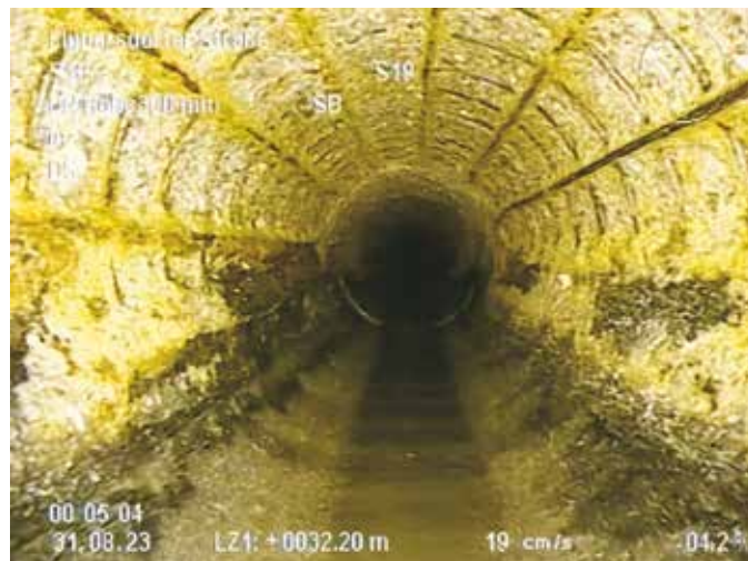
Abbildung 4: Korrosionsschäden in der Druckleitung (Quelle: AZV Olbernhau)
