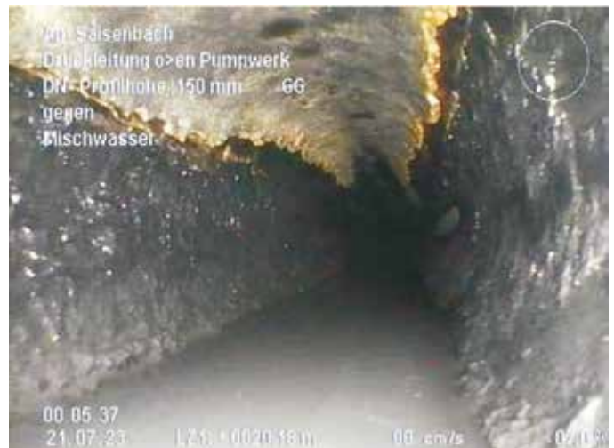
Abbildung 5: Korrosionsschäden in der Freigefälleleitung nach dem Übergabepunkt aus der Druckleitung (Quelle: AZV Olbernhau)
