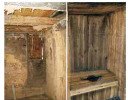
Abb. 4: Äußeres Frauentor, Wohngeschoss Links: Blick vom Küchenraum in die Abortnische (Foto: G. Laßmann), Rechts: Darstellung des möglichen früheren Zustandes in Holz- und Steinbauweise. (Computergrafik: A. Bauer)
