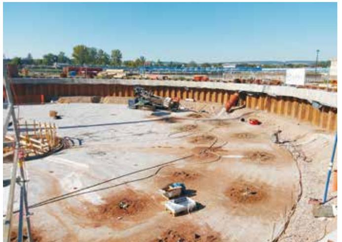
Abb. 7: Einbringung der Mikropfähle zur Auftriebssicherung (Quelle: AFRY Deutschland GmbH)
