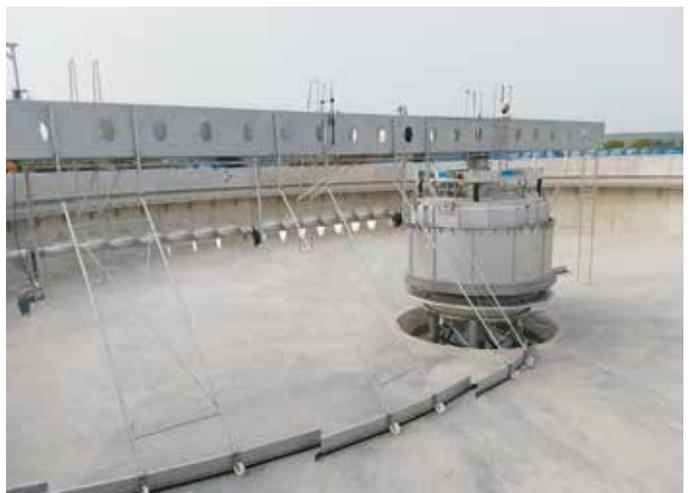
Das Räumfahrwerk läuft auf einer Schiene, es wird über eine Zahnstange zwangsangetrieben. Zur Vermeidung von Algenbewuchs wurde die umlaufende Ablaufrinne abgedeckt ausgeführt (Abb. 10).
