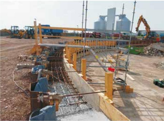
Abb. 4: Betonieren des Druckaussteifungsrings der Umspundung (Quelle: AFRY Deutschland GmbH)
