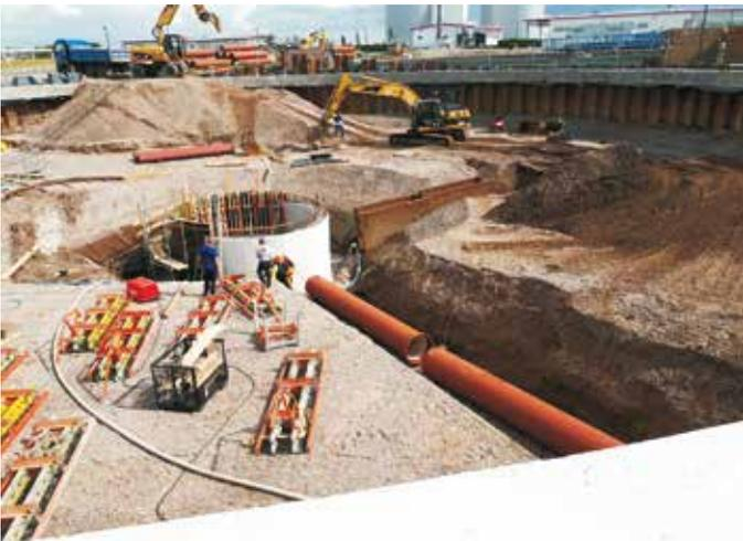
Abb. 6: Verlegung der Leitung zur Beckenbeschickung (Quelle: AFRY Deutschland GmbH)
