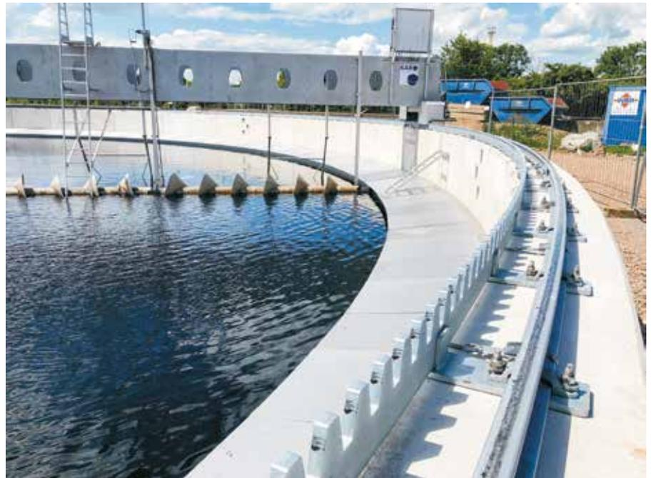
Abb. 10: Nachklärbecken nach Inbetriebnahme (Quelle: AFRY Deutschland GmbH)
