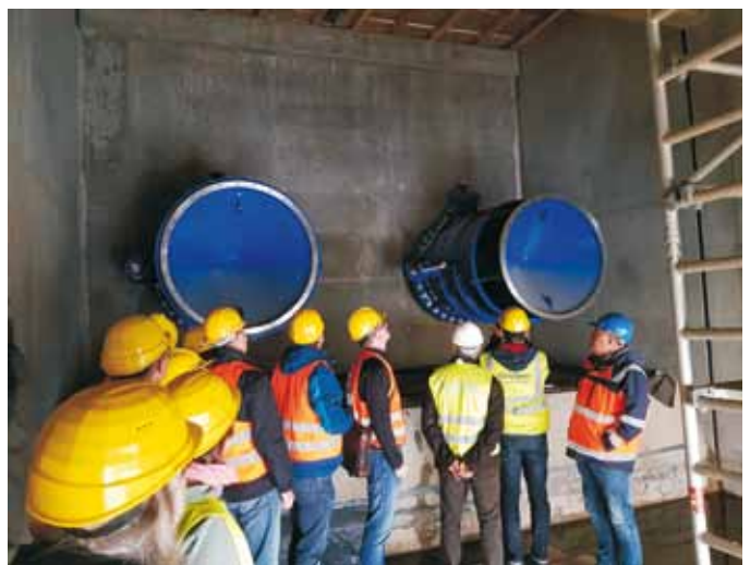
Abb. 2: Toskammer und Kegelstrahlschieber
