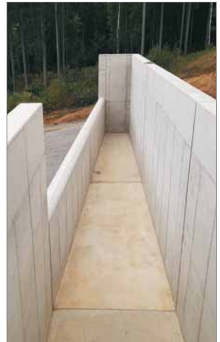
Abb. 5: Sammelrinne Hochwasserentlastung
