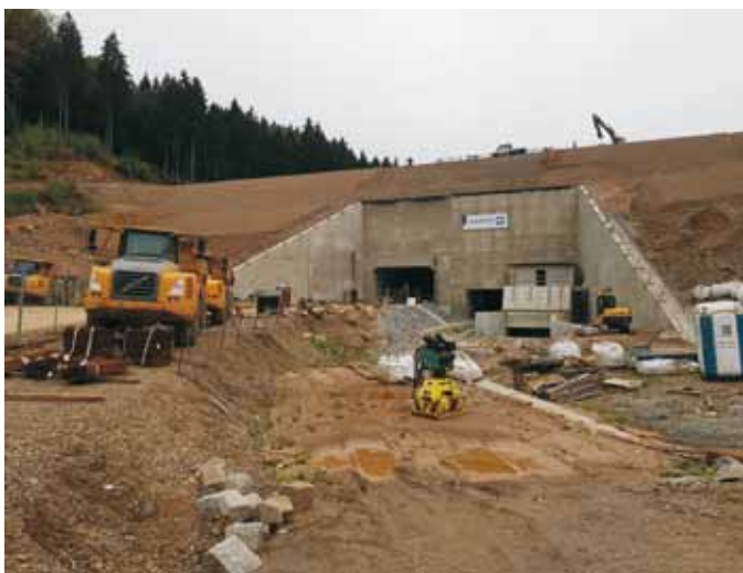
Abb. 1: Ansicht Durchlassbauwerk von der Luftseite
