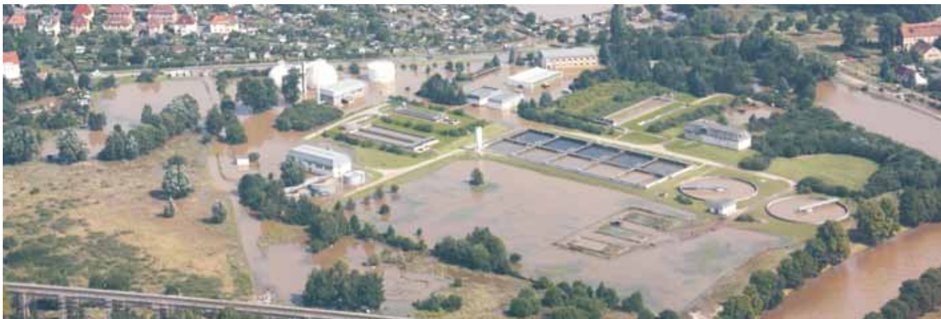
Abb. 1: Kläranlage Zittau (8. August 2010)
