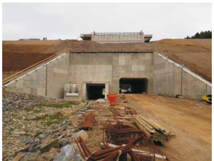
Abb. 4: Ansicht Durchlassbauwerk von der Wasserseite
