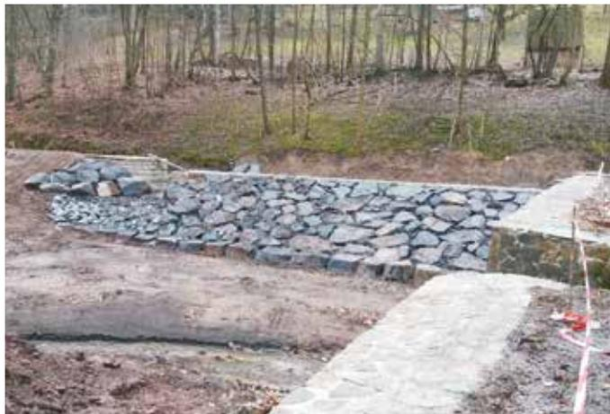
Abb. 14: neue Betonplombe, Grundablass mit Flachschieber und Bedienplattform aus Natursteinen
