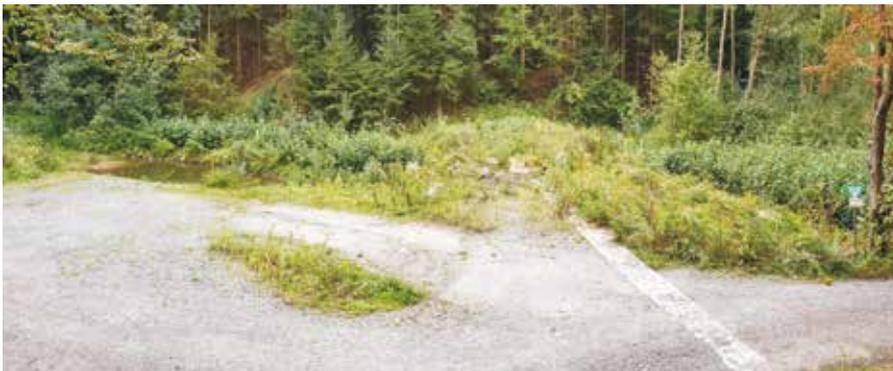
Abb. 9: Sandfang mit Verwallung und Drossel ca. 2 Jahre nach Fertigstellung
