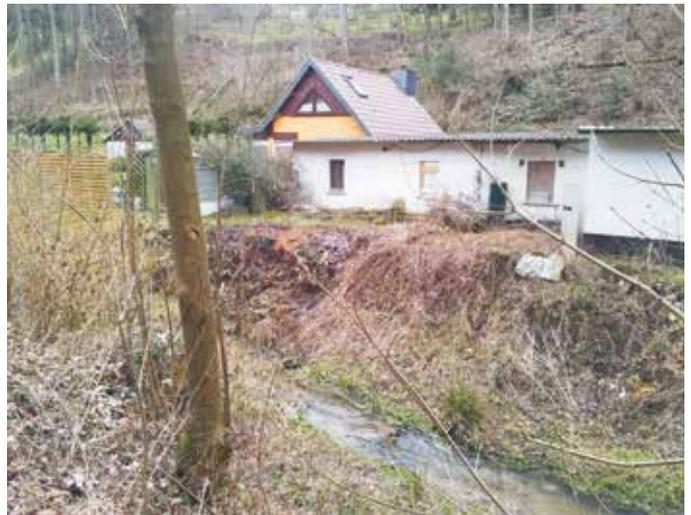
Abb. 5: Böschungserosion im Bereich Gartenanlage
