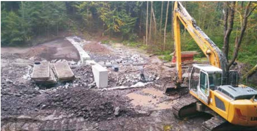
Abb. 8: Verwallung mit Drossel, Kernmauer aus Beton und beidseitiger Anschüttung im Bauzustand
