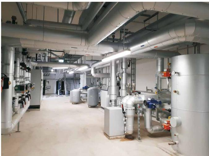
Abb. 4: Kaltwasserverteiler
