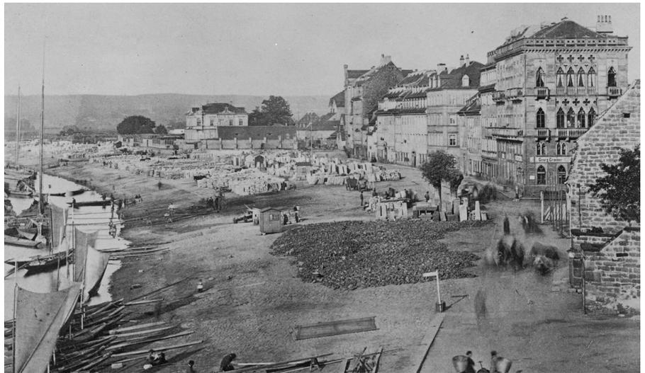
Abb. 5: Auch für den Kanalbau: Sandsteinumschlag und -bearbeitung am noch unbefestigten Elbufer in Höhe der jetzigen Carolabrücke, um 1870
