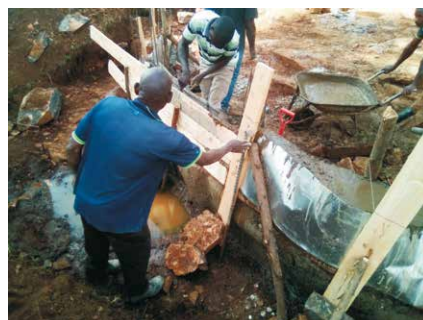
Abb. 3: Projektpartner bei Arbeiten auf der Baustelle
