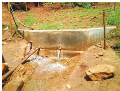
Abb. 4: Gefasste Quelle mit Ausleitung des Wassers
