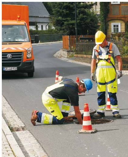
Abb. 4: Fachkraft für Rohr-, Kanal- und Industrieservice (Foto: SOWAG mbH)
