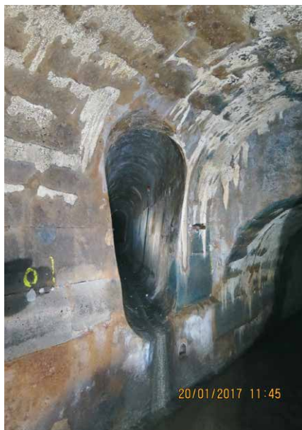
Abb. 4: Kreuzung des alten und neuen Südvorstadtkanals unter dem Postplatz (Foto: F. Männig, 2017)
