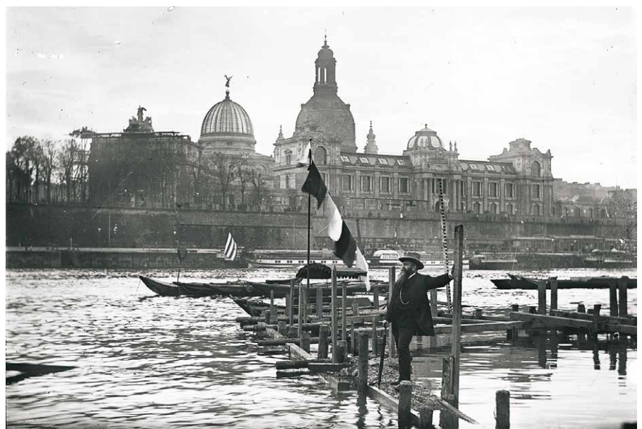
Abb. 5: Die Baustelle des Auslasses Carolabrücke bei erhöhtem Elbpegel um 1894 (Foto: Donadini, www.deutschefotothek.de)
