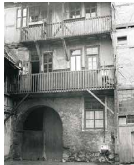
Abb. 1: Zellescher Hof (heute Holzstraße 1) Zweigeschossige Abortanlage mit Wasserzapfstelle vor jedem Abort [verbesserte Körperhygiene]; Zustand um 1940/46 (Quelle: aus Mühlhäuser Museen)
