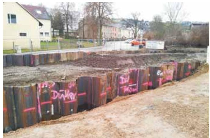
erfolgten die Verfüllung mit bindigem Dichtungsmaterial und eine Bodeninjektion mit einer Dichtwandmasse aus hydraulischen Bindemitteln und Bentonit.
