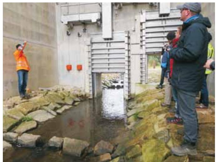
Gleitschützen verschleißbar. Diese werden ölhdraulisch betrieben und sind bei Bedarf beheizbar. Im Hochwasserfall werden die Gleitschützen ab einem Durchfluss von 5 m<sup>3</sup>/s teilgeschlossen und danach auf 1,5 m<sup>3</sup>/s Durchfluss eingestellt. Die Schützen können automatisiert pegelgesteuert oder händisch gesteuert werden. Die Steuerung kann vor Ort am Bedienschrank und am Handbetrieb des Hydraulikaggregates erfolgen.
