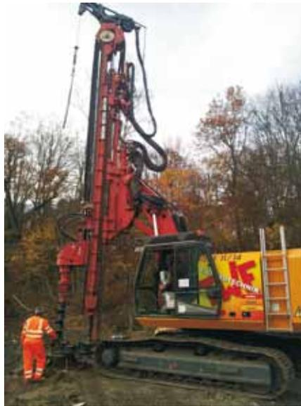
Bild 5: Spundwandrammung mit Vorbohrung
