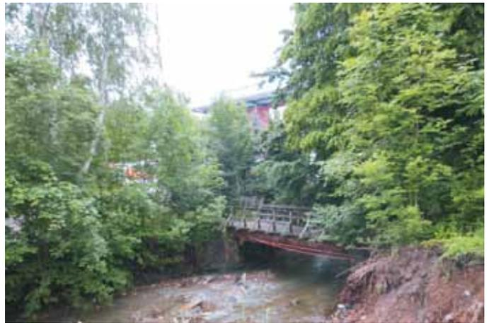
Bild 3: Böschungs- und Sohlenerosion im Bereich Hirschmühle und Freibad [1]
