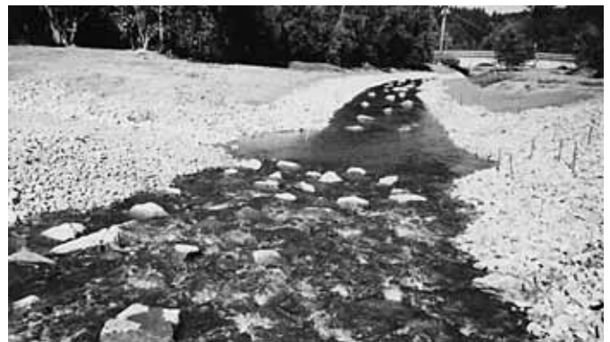
Naturnahe Sohlgleite als Fischaufstieg
