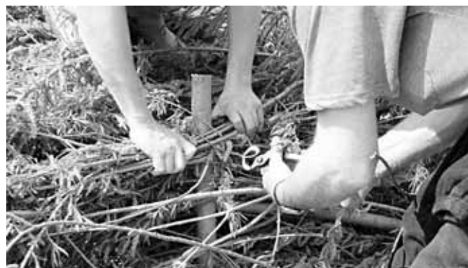
26. April 2006 – Befestigung des oberen Flechtwerkes an der Weidenstange
