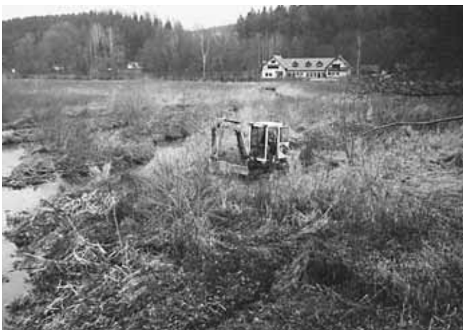
Ausgangszustand, fast vollständige Verlandung durch Spreesedimente
