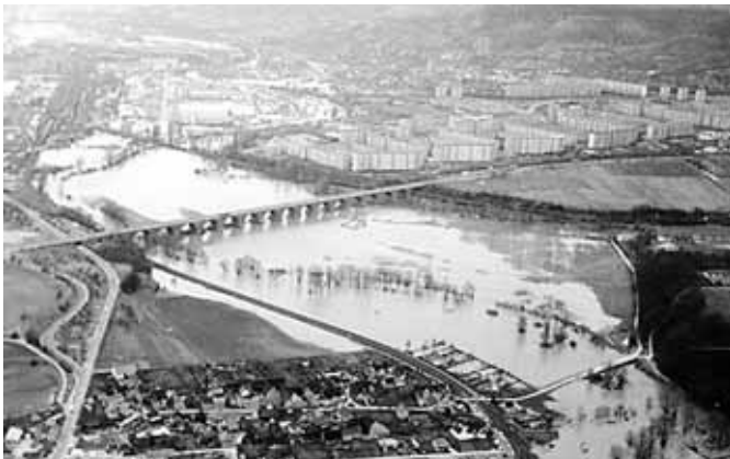
Hochwasserereignis 1994 an der Saale: Bereich Autobahnbrücke Jena
