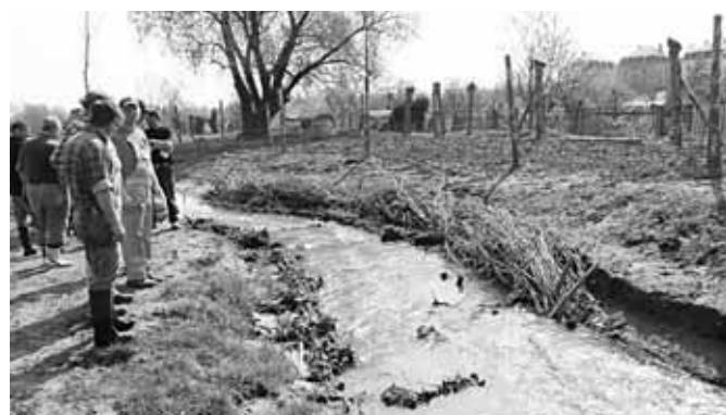
26. April 2006 – Fertiger Flechtzaun mit Sicherung im Anströmbereich
