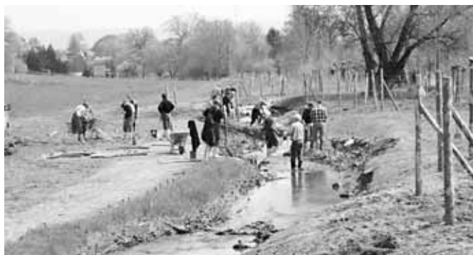
Ufersicherung mittels ingenieurbioologischer Bauweisen am Kaitzbach
