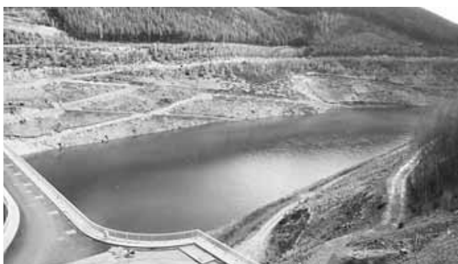
Die Trinkwassertalsperre Leibis/Lichte im März 2006
