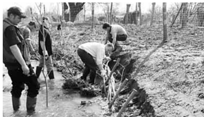
26. April 2006 – Setzen von Weidenstangen für einen Flechtzaun
