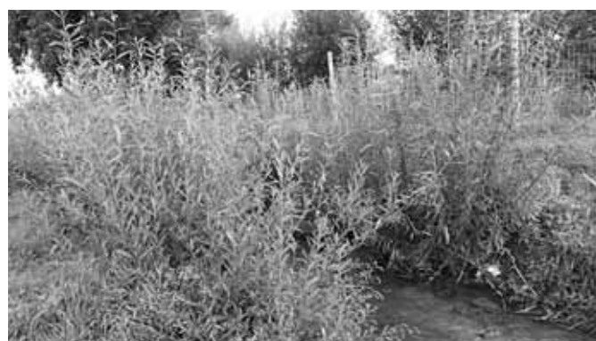
September 2006 – Austrieb des Flechtzaunes (hinten) sowie der Lebendfaschine (vorn)
