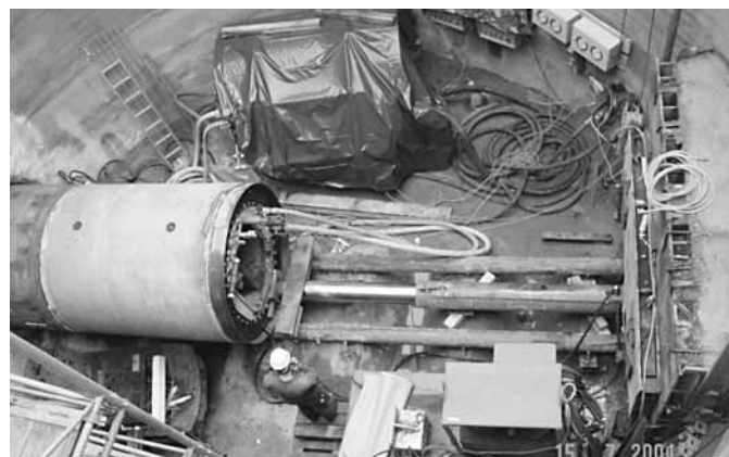
Bild 8: Doppelstartgrube für Rohrvortrieb DN 1600
