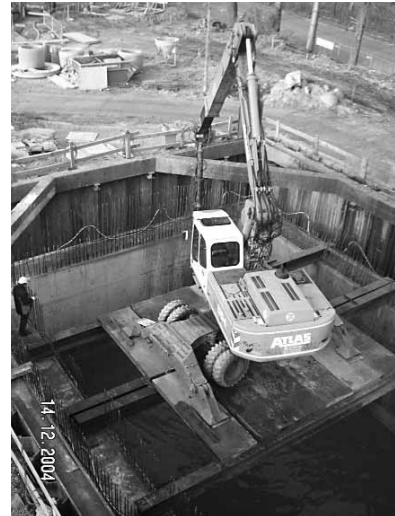
Bild 3: Absenkvorgang des Senkkastens
