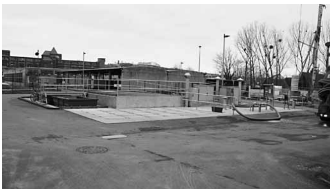
Bild 6: Fäkalannahmestation mit Stapeltank und Entwässerungscontainer
