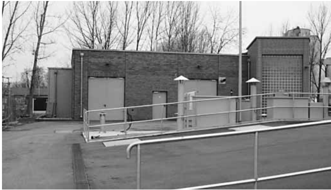
Bild 5: Fertiges Hochbauteil des Zentralpumpwerkes Heidenau
