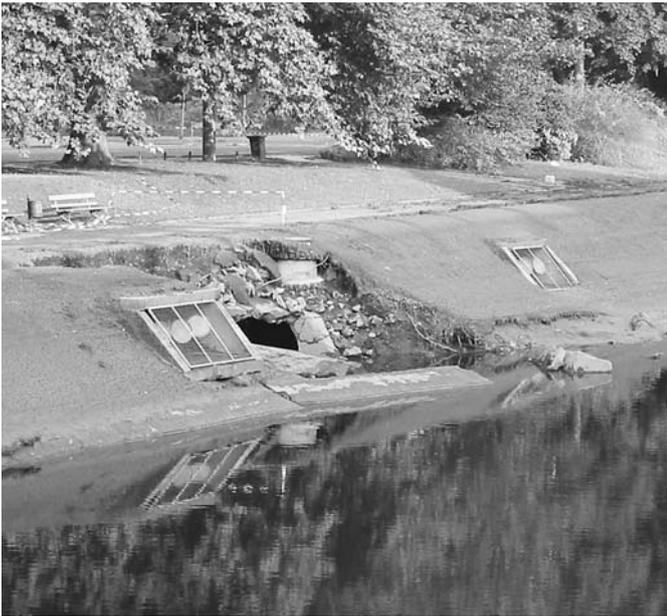
Abb. 1: Schaden am Kanalnetz (Zwingerteich) infolge des Hochwassers vom August 2002
