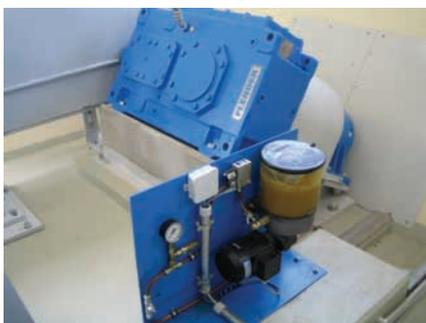
Getriebe-/Lagereinheit mit Zentralschmierung
