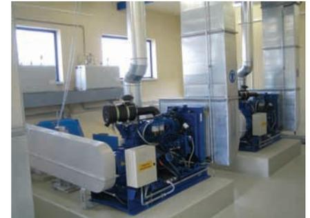
Dieselmotoren mit Kühlflutkanälen und Kraftstoffvorlagetanks
