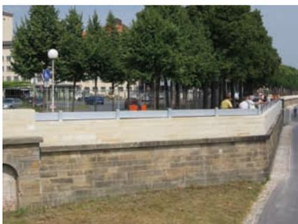
Hochwasserschutzmauer mit aufgesetzten mobilen Elementen im Bereich Neue Terrasse
