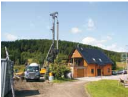
Ausführung der Bohrarbeiten unmittelbar neben dem Wohngebäude
