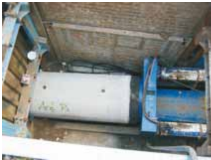
Abb. 3: Unterirdischer Rohrvortrieb
