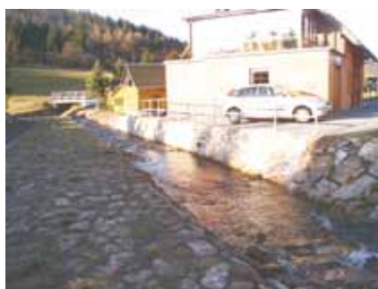
Fertiggestellte Ufermauer mit Bohrpfahlwand
