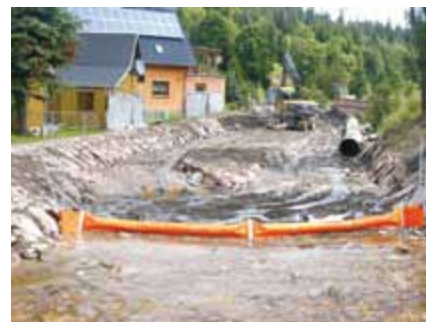
Stationäre Ölsperre während der Bauarbeiten
