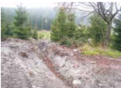
Flutgraben (oberer Abschnitt) am Verteilerbauwerk
