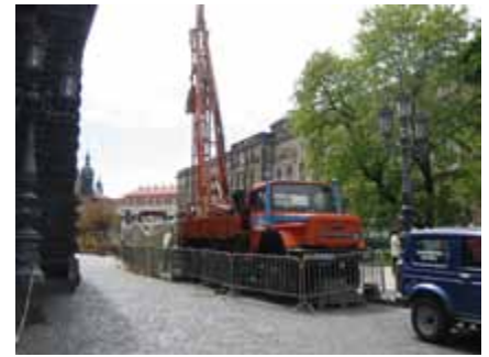
Abb. 1: Brunnenbau an der Semperoper
