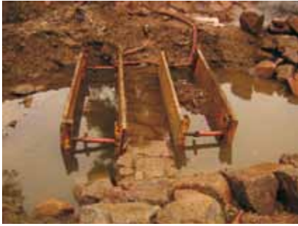
Herdmauerabschluss mit Wasserbausteinen
