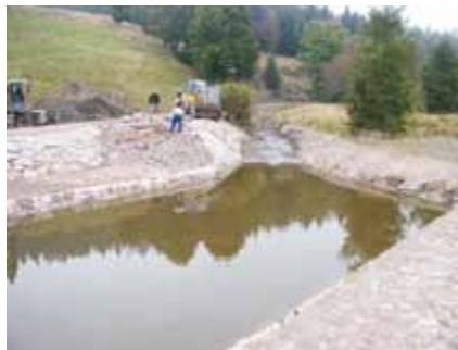
Geschiebefang mit Zufahrtsrampe
