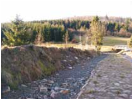
Trocken gefallener Umfluter bei MQ-Abfluss im Warmbach
