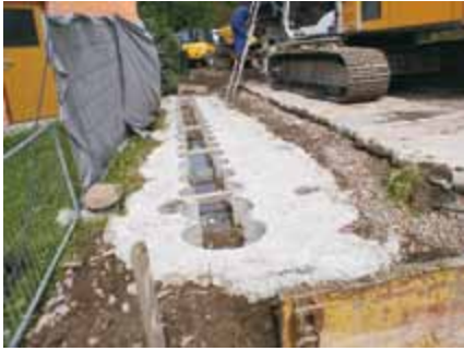
Beginn der Bohrarbeiten für Bohrpfahlwand mit Bohrschablone
