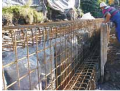
Bewehrung für Vormauerung der Bohrpfahlwand
