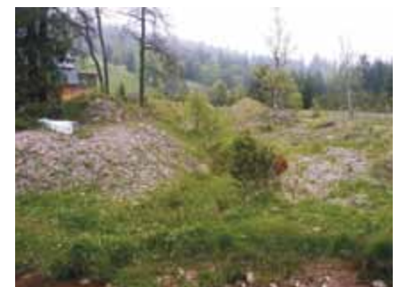
Zustand vor Baubeginn am linken Ufer
