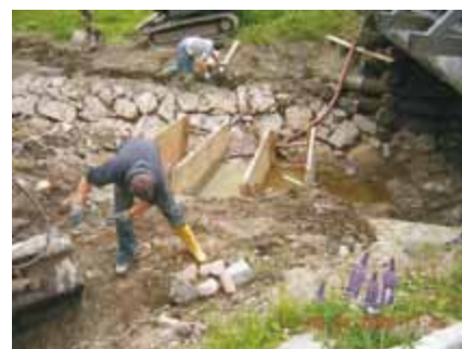
Sohlsicherung mit Querriegel (Herdmauer)
