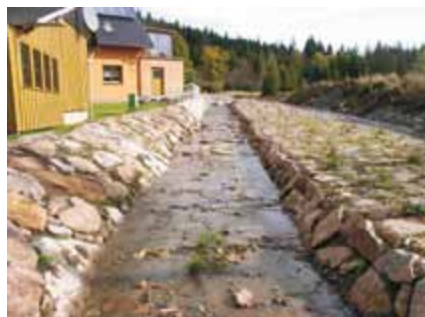
Großer Warmbach und Berme mit Böschungsbefestigung
