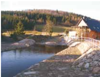
Geschiebefang mit Zufahrtsrampe zur Bauabnahme
