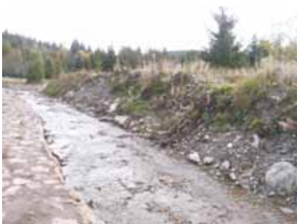
Anspringen des Umfluters bei einem Abfluss > 1 m³/s
