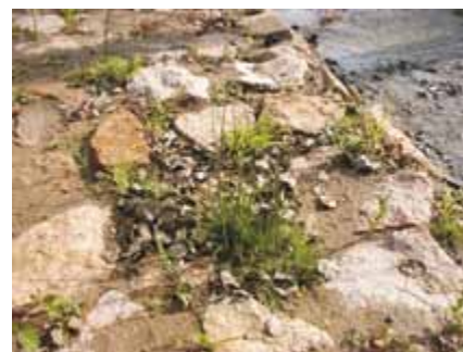
Begrünung mit Röhricht und Stauden auf der Berme
