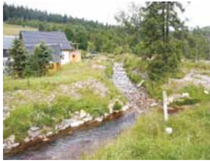
Durch das Hochwasser im Jahr 2002 verlegter Gewässerverlauf des Großen Warmbaches mit Mündung in die Wilde Weißeritz
