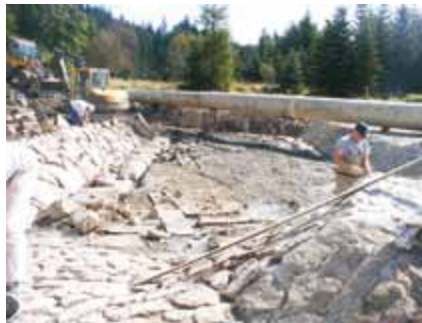
Geschiebefang im Bau mit Wasserhaltung
