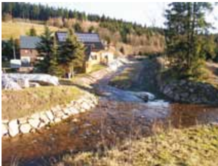
Großer Warmbach (li.), Umfluter (re.) und Wilde Weißeritz (im Vordergrund) nach Baufertigstellung
