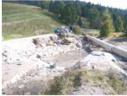
Wasserhaltung im Bereich Verteilerbauwerk
