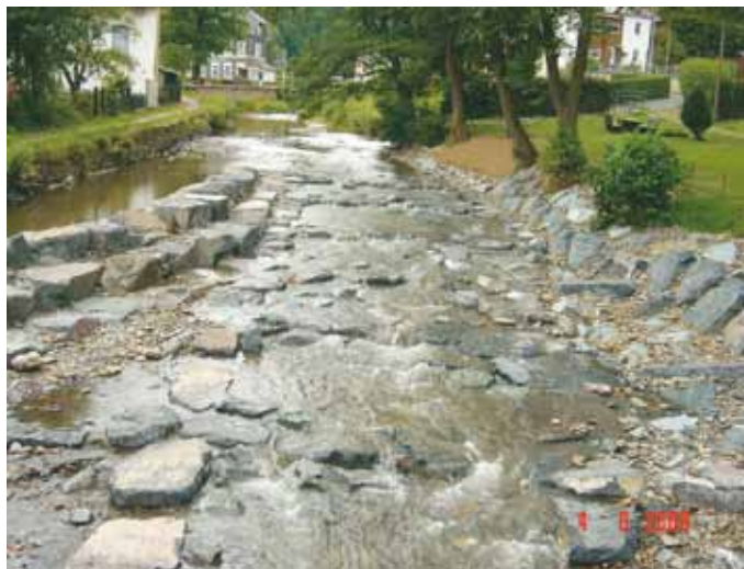
Abb. 11: Hertwigwehr fertiggestellt mit Leitwand zur Sicherung des Zulaufes zur Wasserkraftanlage der Gemeinde
