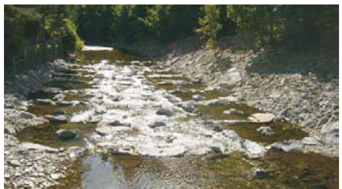
Abb. 2: Riegelstruktur am ehemaligen Kernstalwehr im Gewässer Schwarza
