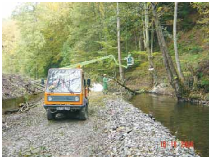
Abb. 6: Kürzung des Uferbewuchses zur Baufeldfreimachung
