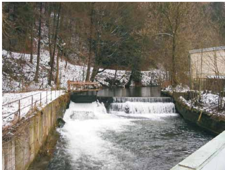
Abb. 4: Rohrbachwehr vor Umbau
