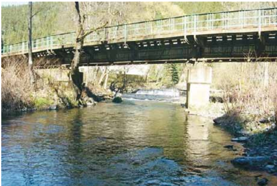
Abb. 3: Beispiel für Problemlösung - Eisenbahnbrücke im Projektgebiet des Kädingsmühlenwehres
