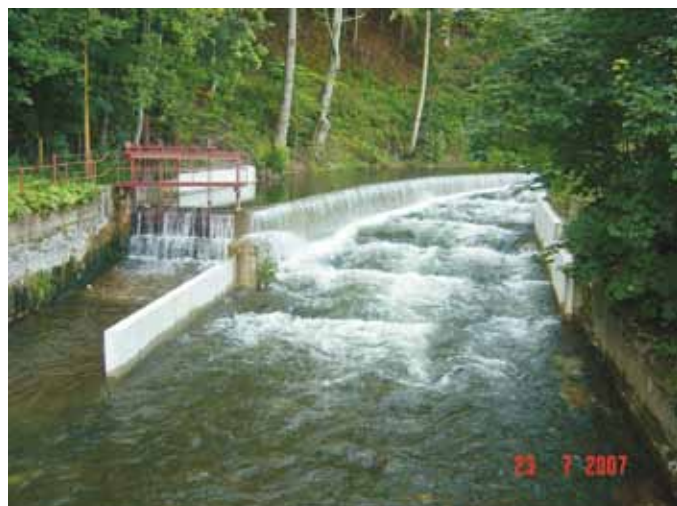
Abb. 5: Rohrbachwehr nach Rückbau mit Abschlag für Mühlgraben (Wasserkraftnutzung gemäß altem Wasserrecht)
