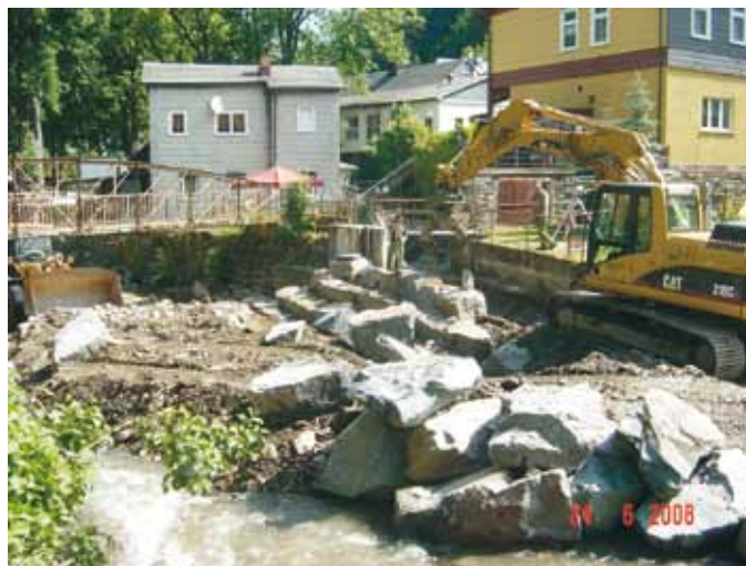
Abb. 10: Hertwigwehr im Rückbau, Setzen der Leitwand mit Blocksteinen
