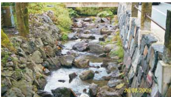
Abb. 1: Riegelstruktur am ehemaligen Schneidmühlenwehr im sehr schmalen Gebirgsbach Masse
