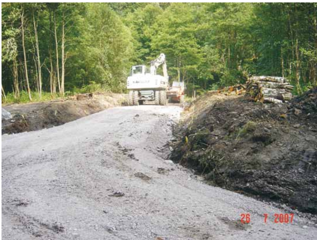
Abb. 7: Zuwegung zum Kernstalwehr
