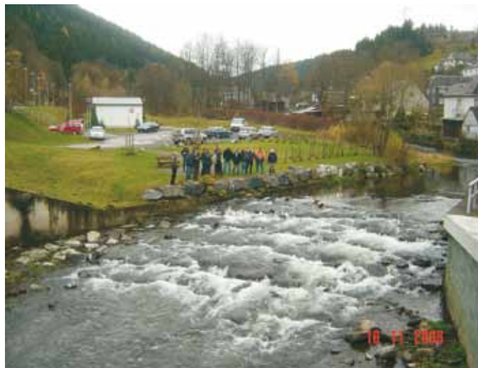
Abb. 12: Behördenabnahme einer Sohlgleite
