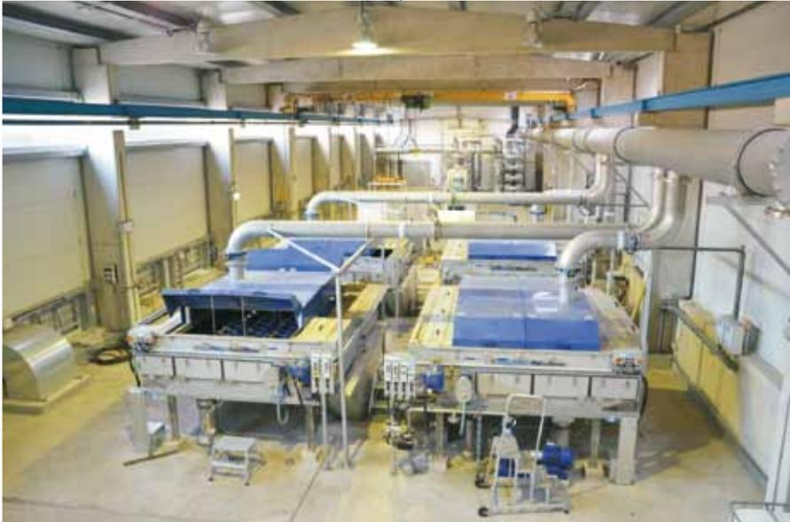
Abb. 3: Maschinelle Überschussschlammentwässerung
