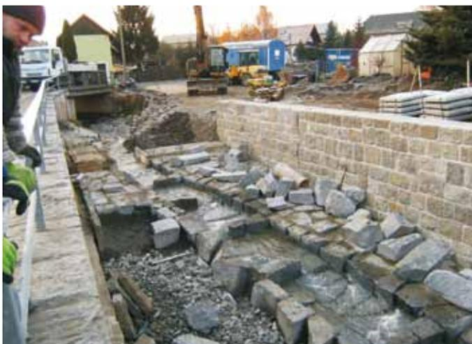
Abb. 6: Bau der Sohlgleite mit Niedrigwasserrinne
