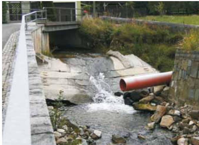
Abb. 4: Notsicherung der Abbruchkante
