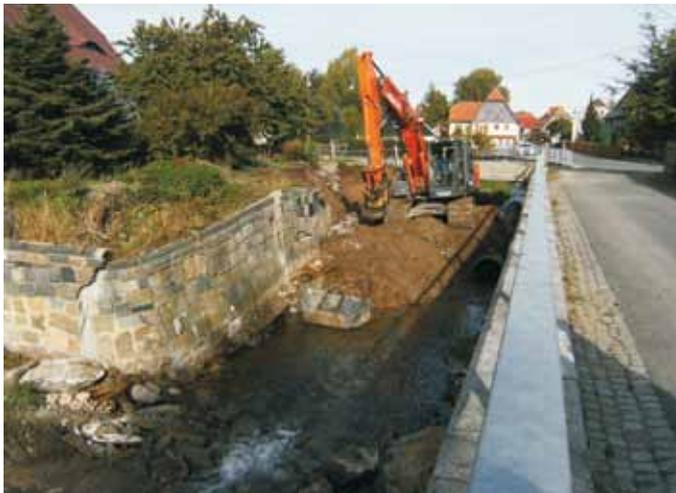
Abb. 3: Bauvorbereitung des Vorhabens, Abbruch der zerstörten Ufermauer
