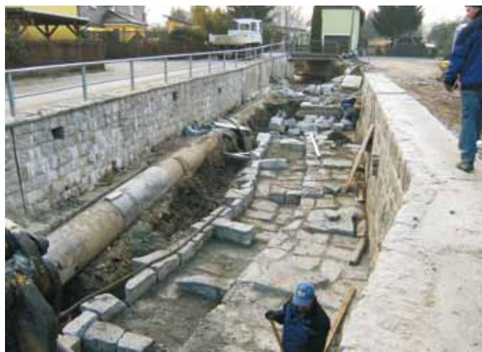
gebaut und auf den linken Rand der neuen Sohlgleite wird zur Wasserführung/Wasserhaltung ein 0,5 m hoher Betonkragen aufbetoniert. Im Oberwasser/Unterwasser vor und nach den Sohlschwellen wird der Betonkragen auf 1 m Höhe hochgezogen.
