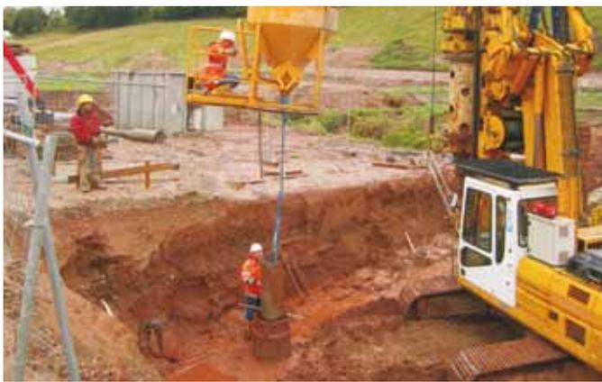
Abb. 15: Einbau der mineralischen Dichtung
