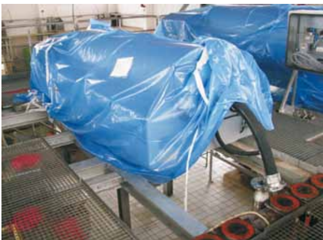
Abb. 5: Installation der neuen Maschinen
