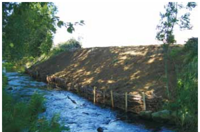
Aufbau und Sicherung eines Uferabschnittes an der Notter: Uferabbruch nahe Körner (links); neu aufgebauter und gesicherter Uferabschnitt (rechts)
