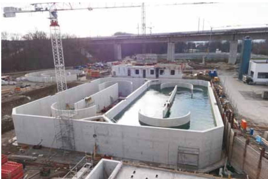
Abb. 2: Belebungsbecken; mit Betriebsgebäude, Anaerob-/Havarie-Kombibecken und ICE-Talbrücke (Hintergrund) und Maschinenhaus Faulung (Vordergrund)
