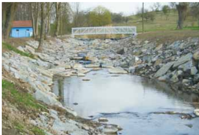
Umbau des Überfallwehres am Flechtaer Bach in Höngeda zur Sohlgleite (Bauzeit 2011-2012): oberer Abschnitt der Sohlgleite (links); unterer Abschnitt der Sohlgleite (rechts)
