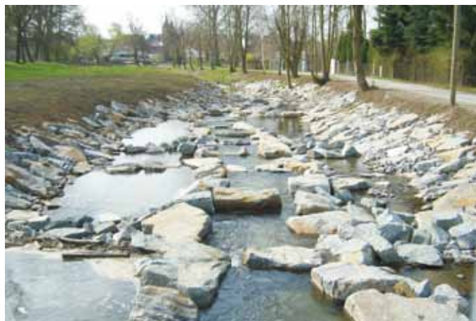
Umbau des Überfallwehres am Flechtaer Bach in Höngeda zur Sohlgleite (Bauzeit 2011-2012): oberer Abschnitt der Sohlgleite (links); unterer Abschnitt der Sohlgleite (rechts)
