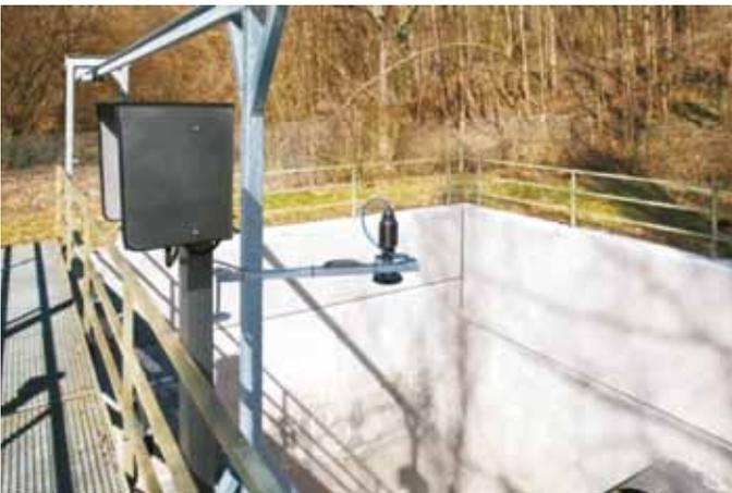
Radarsensoren messen zuverlässig die Füllhöhe, unbeeinflusst von starkem Wind, Regen oder Schneefall.
