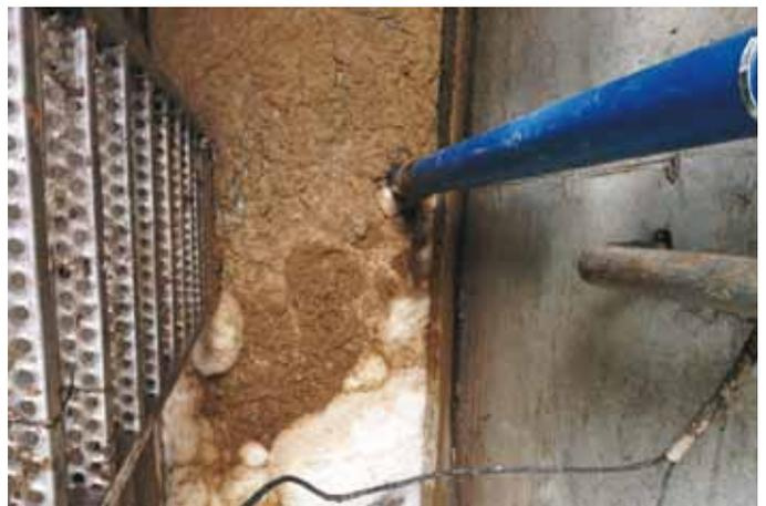
Anwendung 4: Radarsensor bei schäumendem Abwasser. Die Messung mit Radartechnologie ermöglicht sogar bei Schaum eine hohe Messsicherheit.
