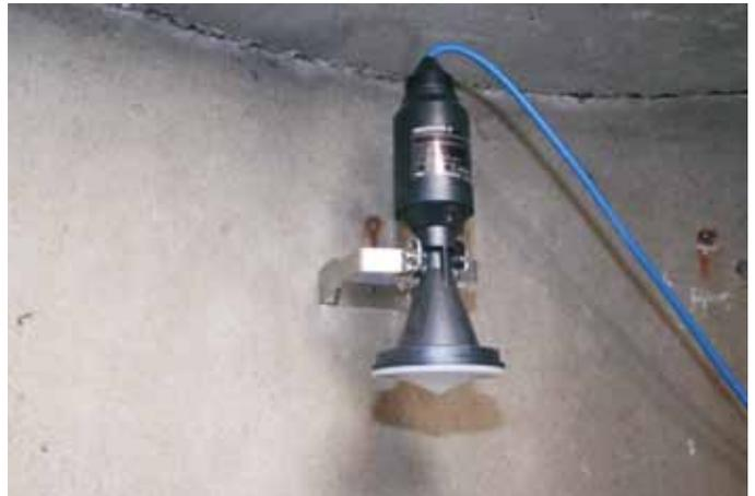
Anwendung 2: Radarsensor am offenen Rückhaltebecken.
