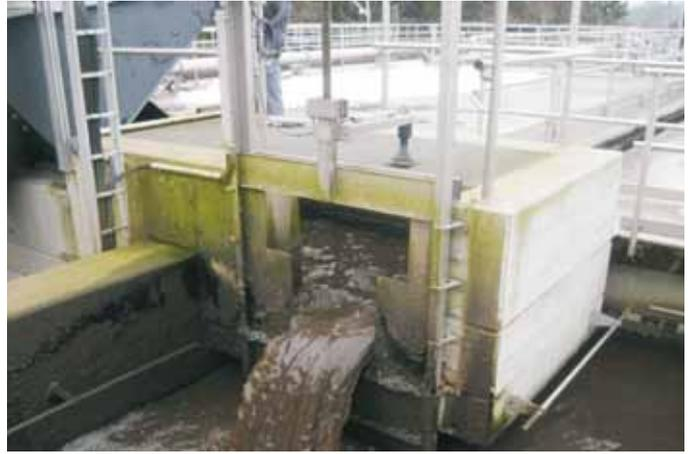
Anwendung 3: Radarsensor am offenen Gerinne und am Überfallwehr. Radargeräte sind unbeeinflusst von Sonneneinstrahlung und Temperaturänderungen. Das bedeutet zuverlässigere und hochgenaue Messergebnisse.
