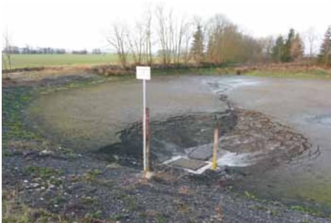
Abb. 3: Abgestauter Speicher, Sedimentstärke November 2012
