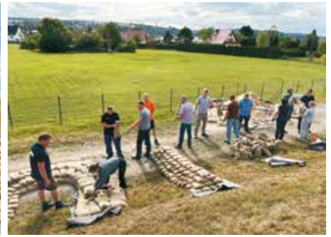
Nach dem Befüllen werden die Sandsäcke zur Sicherung des Deiches bei Austritt von Sickerwasser am Deichfuß fachgerecht verlegt. (Fotos: M. Schulze, LTV)
