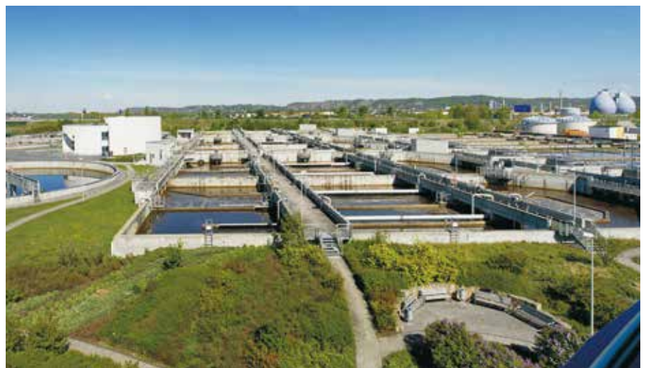
Abb. 3: Kläranlage Dresden-Kaditz (Quelle: Stadtentwässerung Dresden, https://www.dresden.de/de/rathaus/aemter-und-einrichtungen/unternehmen/stadtentwaesserung.php?pk_kwd=Stadtentwaesserung , Quellenanforderung unter service@stadtentwaesserung-dresden.de )
