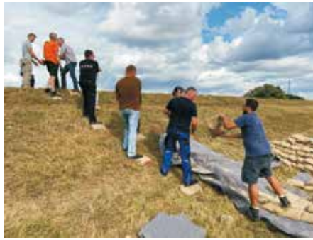
Nach dem Befüllen werden die Sandsäcke zur Sicherung des Deiches bei Austritt von Sickerwasser am Deichfuß fachgerecht verlegt. (Fotos: M. Schulze, LTV)
