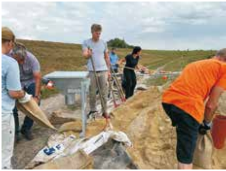
Nach dem Befüllen werden die Sandsäcke zur Sicherung des Deiches bei Austritt von Sickerwasser am Deichfuß fachgerecht verlegt. (Fotos: M. Schulze, LTV)
