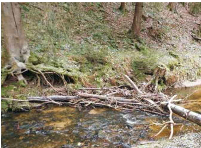
Abb. 3: Totholz unterhalb der Eisenbahnbrücke im Zeitgrund im Januar 2024 (Foto: Birgit Ahrens)
