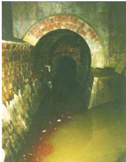
Abb. 1: Zusammenführung der Eiprofile Thomas-Müntzer-Straße/Bahnhofstraße (Foto: D. Keßler)
