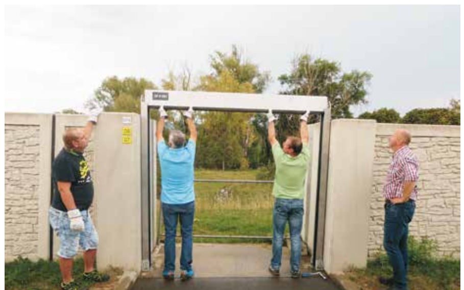
Die Teilnehmer üben den Einbau der Dammbalken für den Ernstfall. (Foto: Gerlinde Weber)
