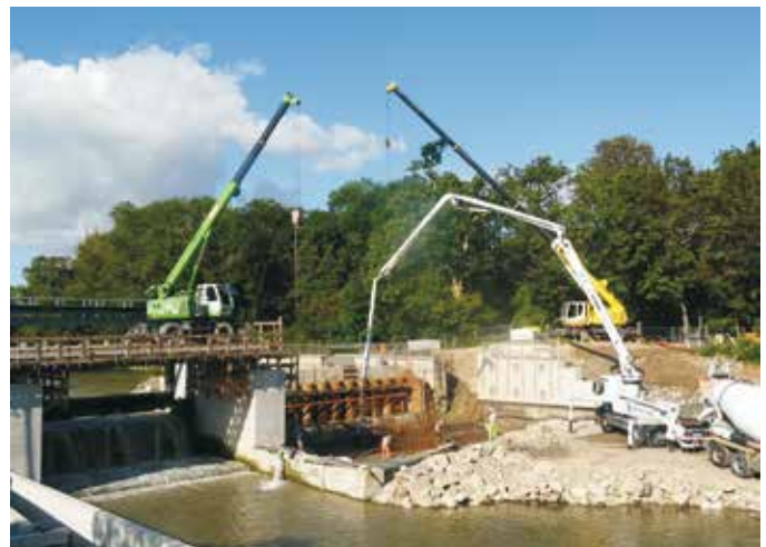
Abb. 7: Betonage Wehrsohle 2. Bauabschnitt (© Tractebel GmbH)
