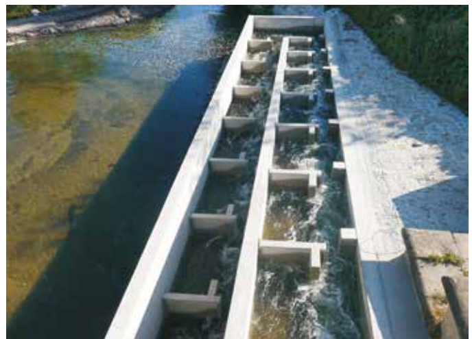
Abb. 2: Fischaufstiegsanlage im Testbetrieb (© Tractebel GmbH)
