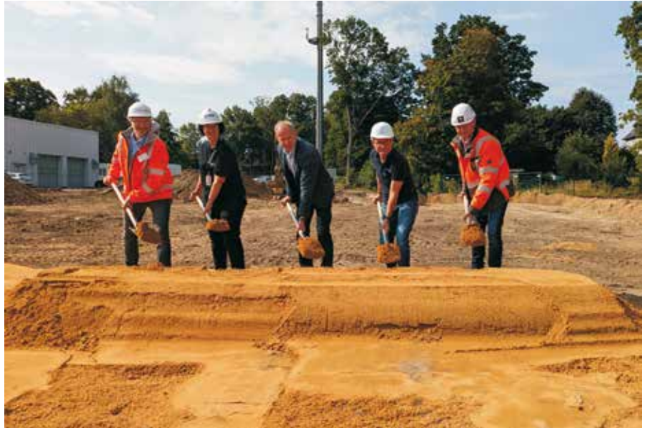
Abb. 1: Spatenstich des Großprojektes Umbau Zulaufbereich (v.l. Herr Kropp – Betriebsleiter ESC, Frau Sundheim – Abteilungsleiterin Kläranlage, Herr Kunze – Bürgermeister Stadt Chemnitz, Herr Schneider – Hydro-Ingenieur und Herr Möller – Implenia), (Quelle: Entsorgungsbetrieb der Stadt Chemnitz (ESC))
