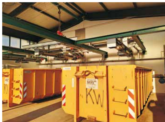
Abb. 6: Schlammaustrag in der Containerhalle (Foto: AFRY Deutschland GmbH)
