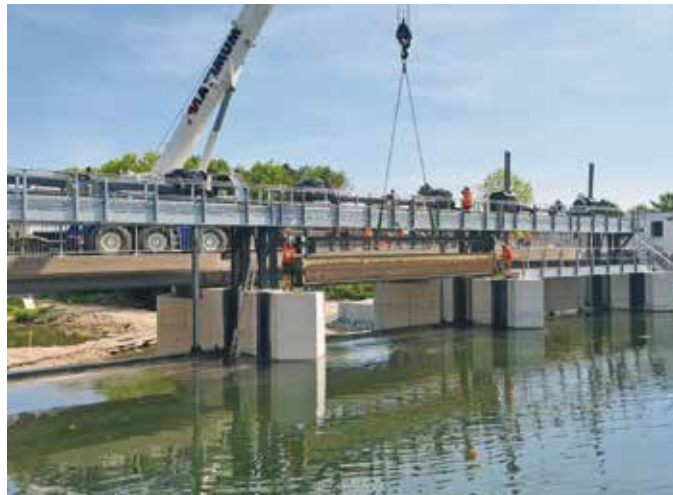
Abb. 10: Einheben Dammbalken im Rahmen der Funktionsprobe (© Tractebel GmbH)
