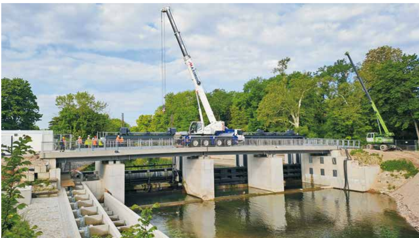
Abb. 9: Unterwasseransicht Wehr mit Wehrverschlüssen zur Funktionsprobe (© Tractebel GmbH)
