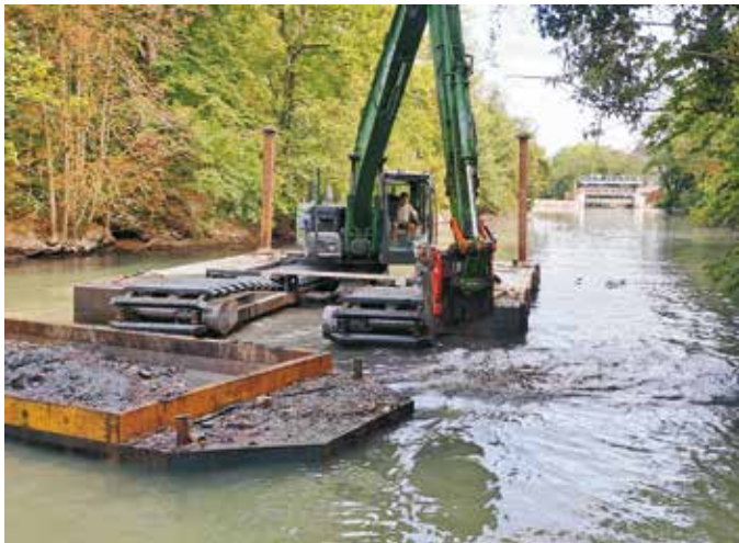
Abb. 8: Gewässerabau mit Schwimmbagger und Schute (© Tractebel GmbH)
