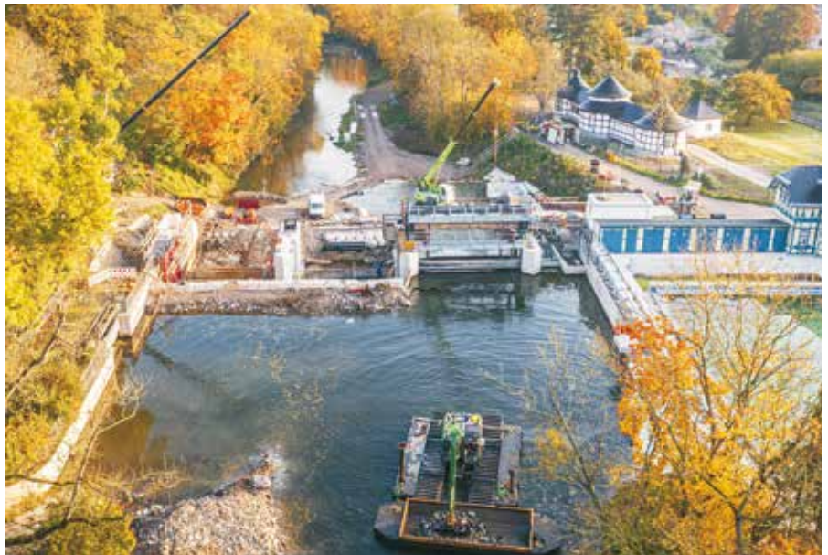
Abb. 5: Baugrube 2. Bauabschnitt, Abfluss über rechtes Wehrfeld (© Landeshauptstadt Erfurt, Stadtverwaltung)
