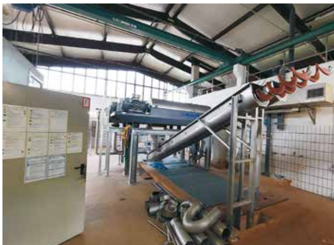
Abb. 3: Montagearbeiten am Spiralförderer (Foto: AFRY Deutschland GmbH)
