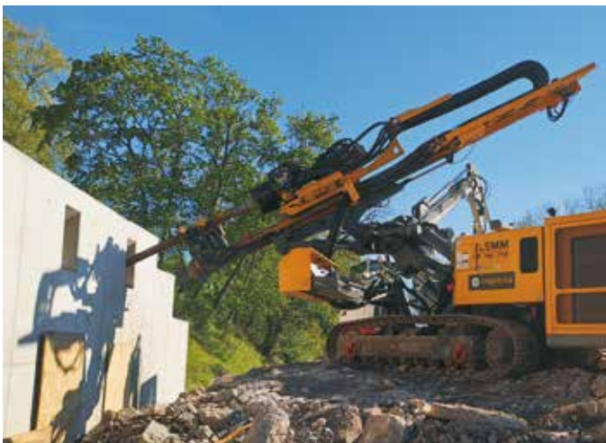
Abb. 6: Rückverankerung Vorsatzschale linkes Widerlager (© Tractebel GmbH)
