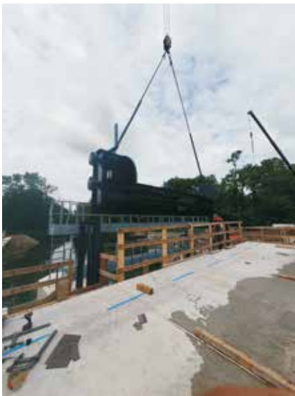
Abb. 4: Montage Hubschütz mit aufgesetzter Fischbauchklappe im rechten Wehrfeld (© 2025 Metallbau-Wasserkraft Onnen Krieger GmbH & Co. KG)
