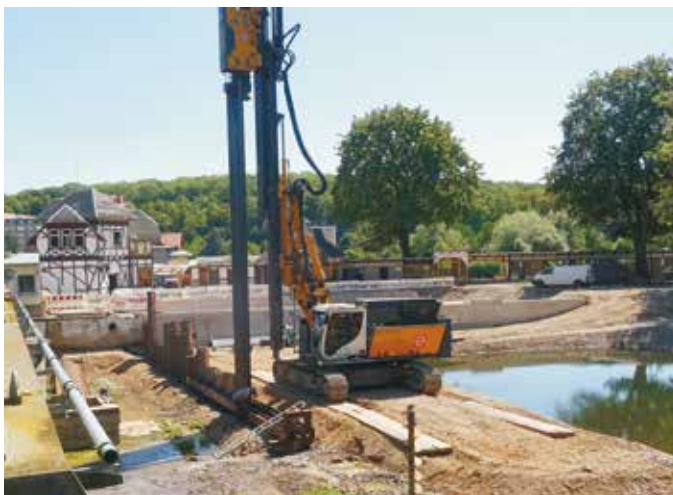
Abb. 1: Spundwandeinbau Dichtwand im Oberwasser (© Tractebel GmbH)
