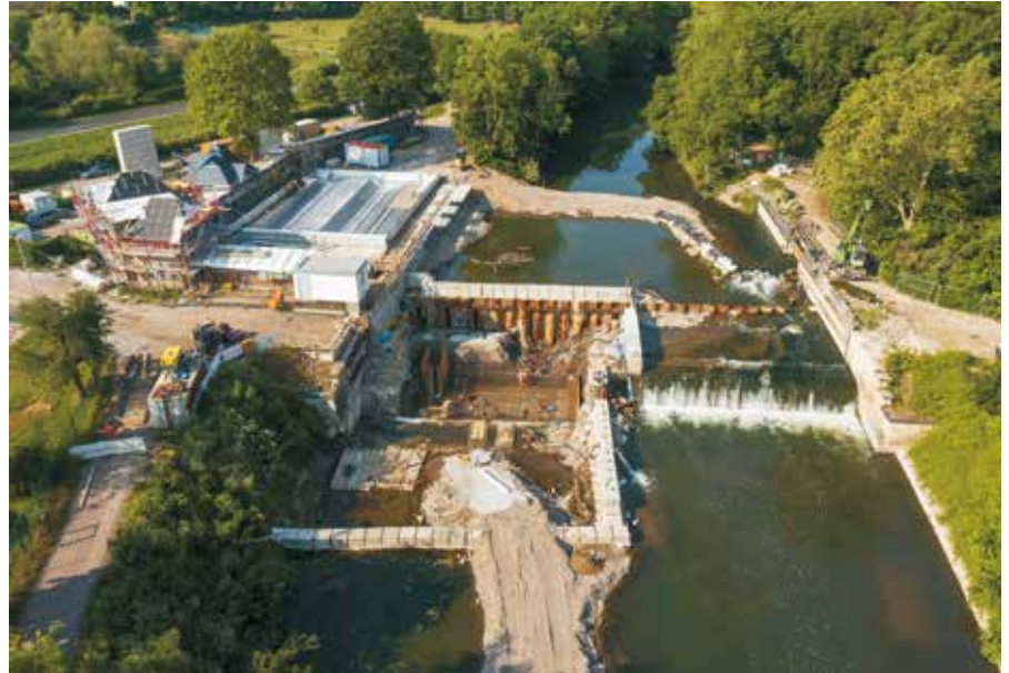
Abb. 3: Baugrube 1. Bauabschnitt mit Wasserhaltungsdamm im Oberwasser (© Landeshauptstadt Erfurt, Stadtverwaltung)
