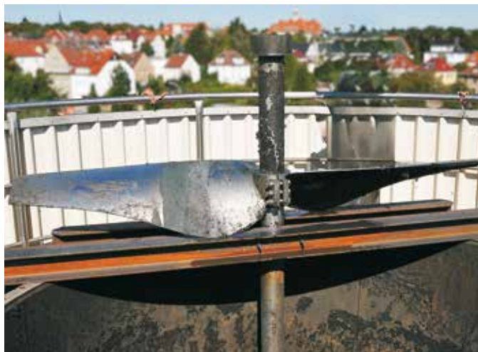
Abb. 4: Fertige Klemmverbindung der Rührwerkswelle (Quelle: SOWAG mbH Zittau)
