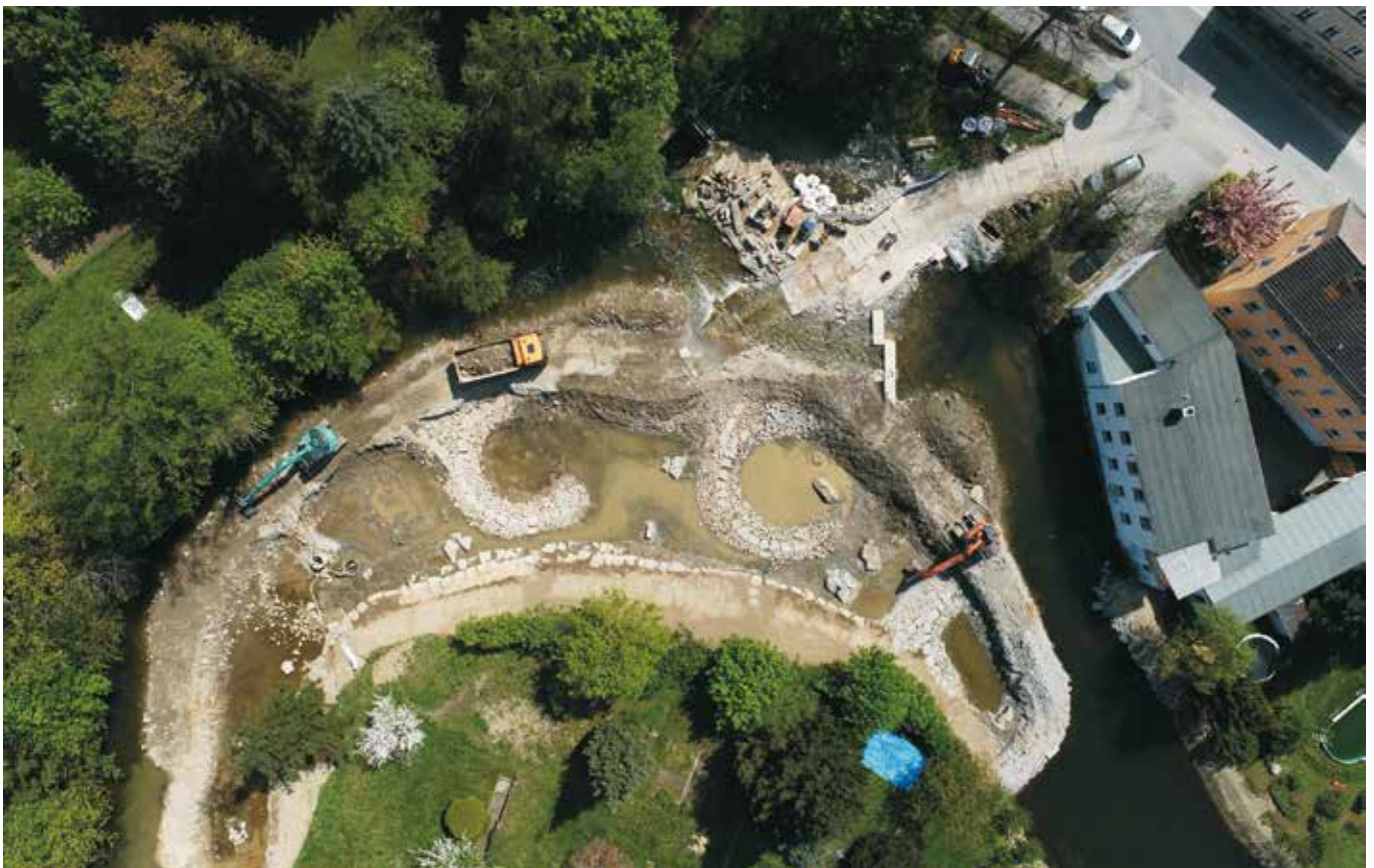
Abb. 1: Drohnfoto, Schneckenbuhnen im Bau an der Spree in Bautzen (Quelle: BauCom, 2024)
