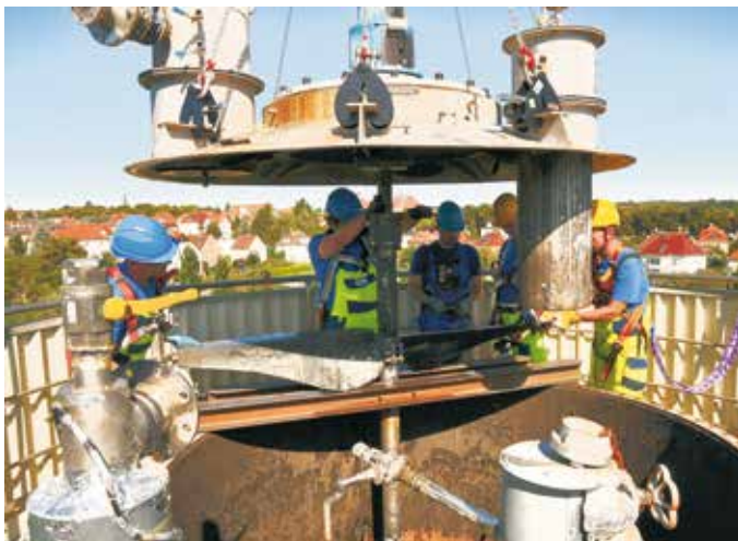
Abb. 3: Montage der Klemmverbindung der Rührwerkswelle (Quelle: SOWAG mbH Zittau)
