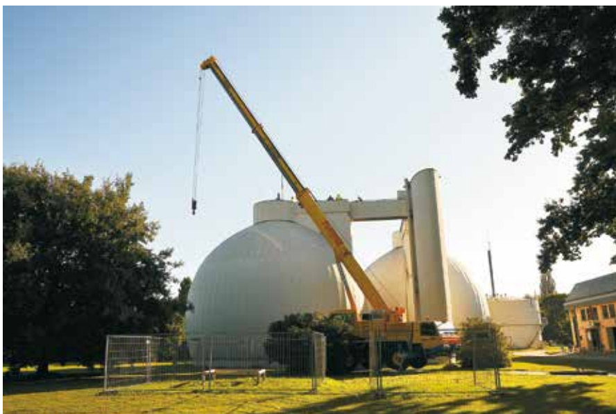
Abb. 6: Rückbau des Dom (Quelle: SOWAG mbH Zittau)
