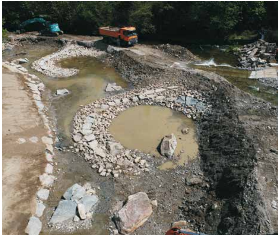
Abb. 4: Schneckenbuhnen und Baustraße innerhalb der Spree, Spreeumleitung bauzeitlich (Quelle: BauCom, 2024)
