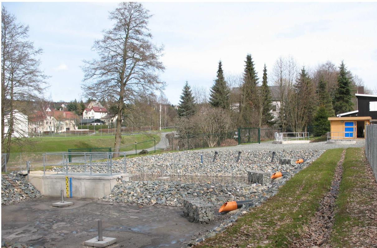
**Abbildung 2** Kläranlage Friesener Berg (Frühjahr 2010). Im Vordergrund die unbepflanzte Teilfläche der ersten Filterstufe
