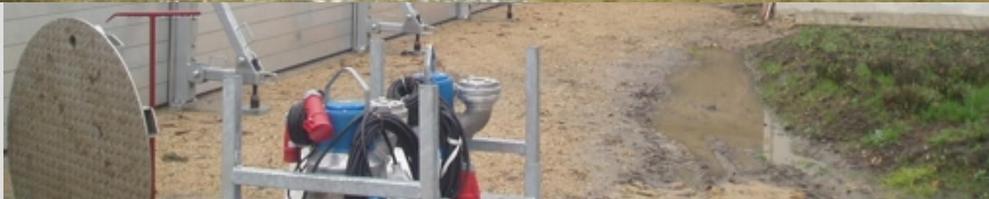
Sicherung des Klostergeländes mit mobilen Hochwasserschutzelementen
