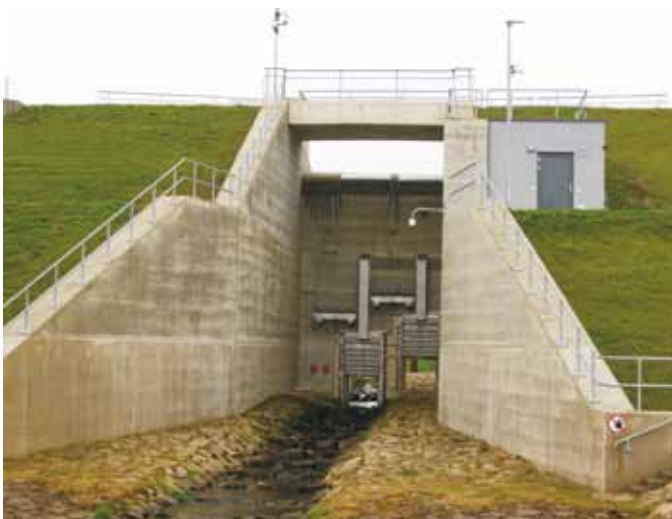
Blick in die Ökoschlucht mit den Betriebseinrichtungen
