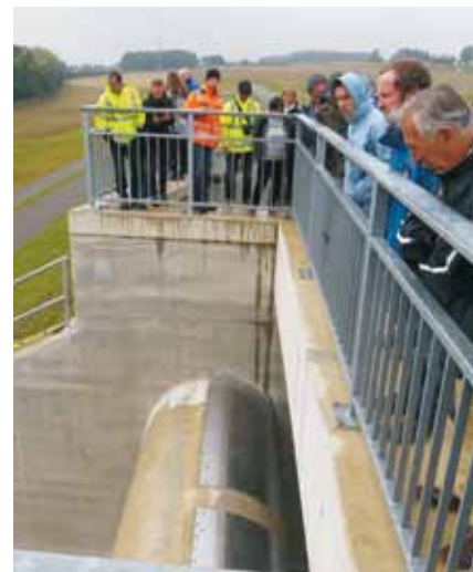
Besichtigung des Hochwasserüberlaufs von der Dammkrone aus
